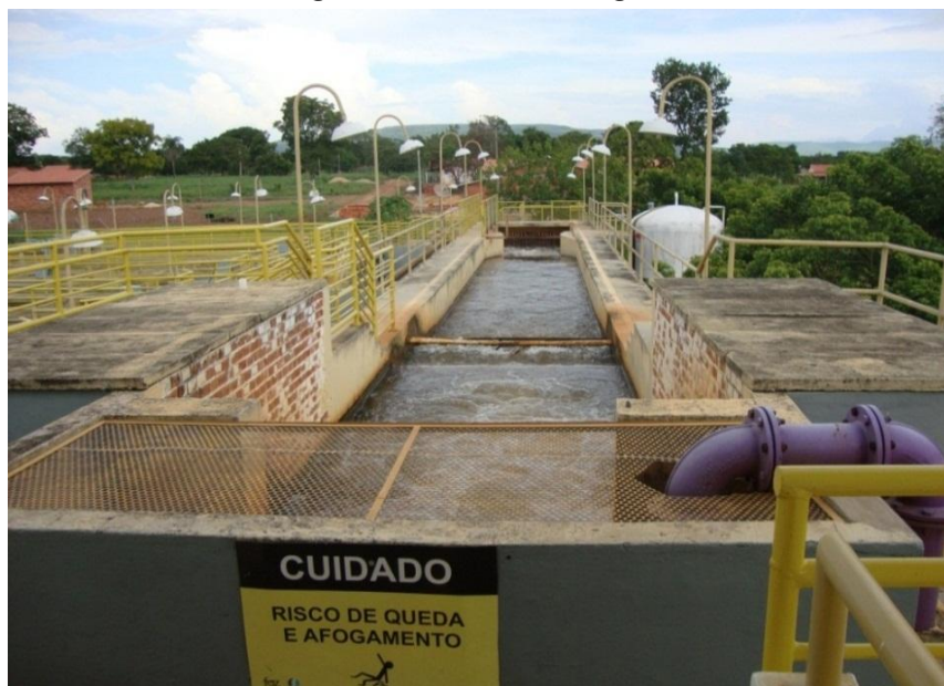
Figura 21. Caixa de chegada
