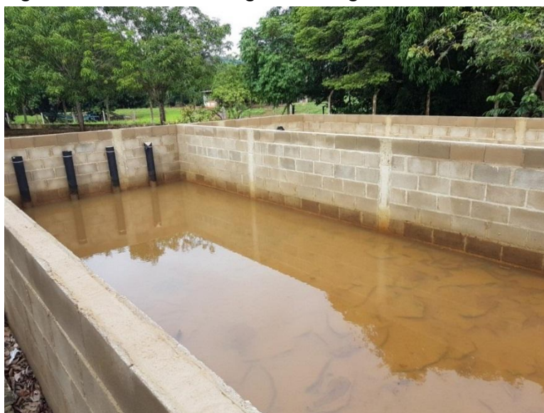
Figura 39. Tratamento da água de lavagem dos filtros
