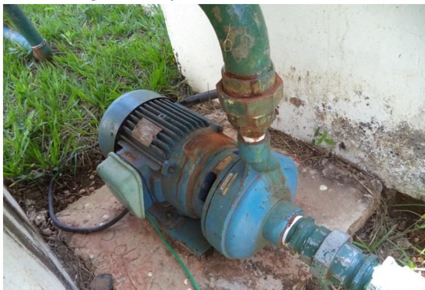
Figura 53. Conjunto motor-bomba RAP 001
