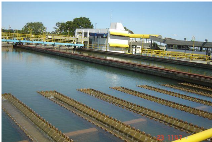
Figura 24. Tanques de decantação ETA 6 – Sistema Taquarussu
