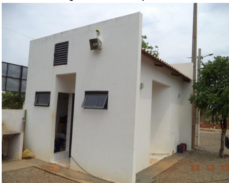
Figura 110. Casa do operador
