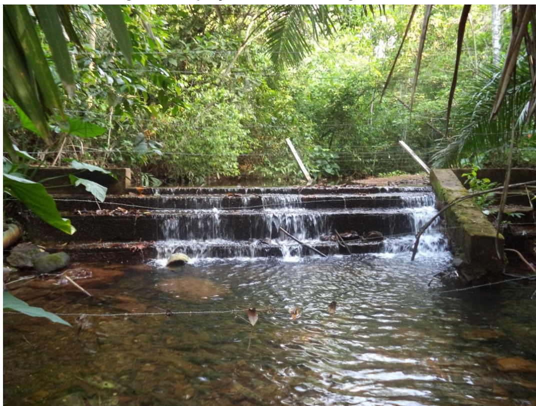
Figura 57. Captação ETA 007 – Córrego Roncador
