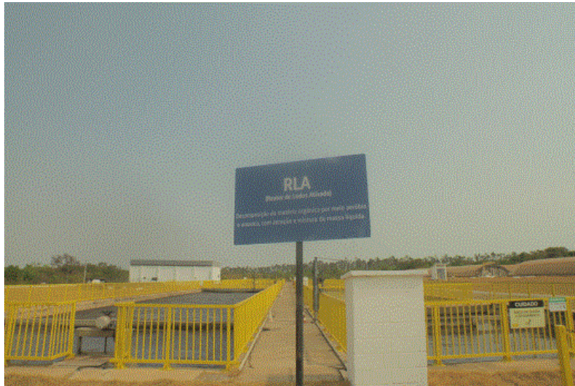
Figura 93. Reator de lodo ativado
