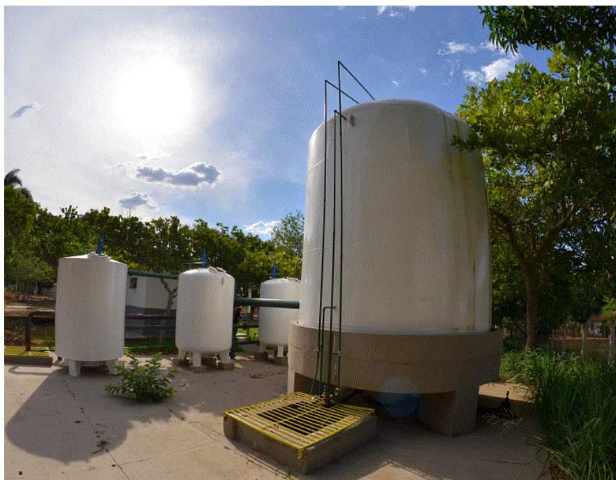
Figura 58. Sistema de Tratamento ETA 007 em Taquarussu – Floco-decantação e Filtros percoladores
