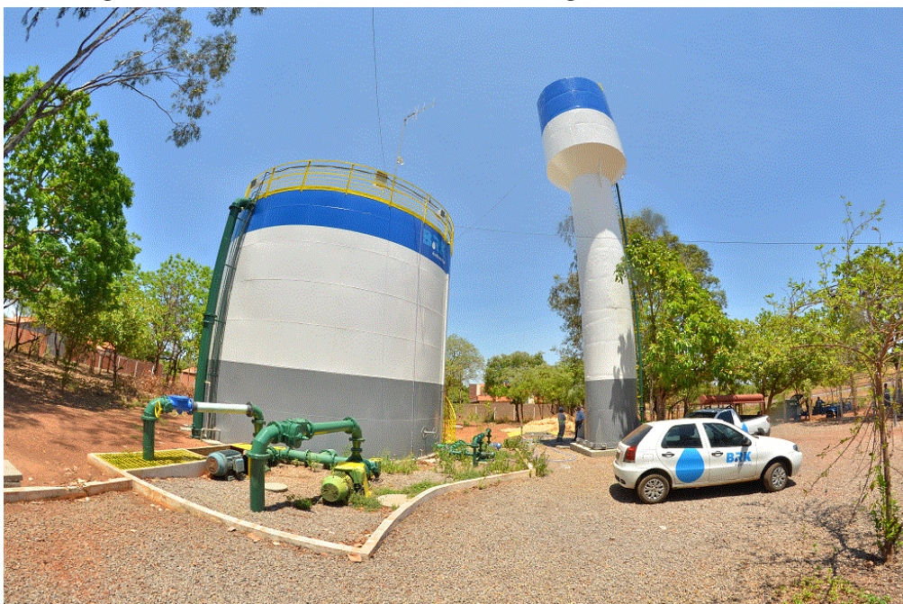
Figura 49. RAP 013 e REL 014 – recebem água tratada da UTS 002.
