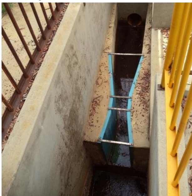
Figura 74. Calha Parshall de Saída
