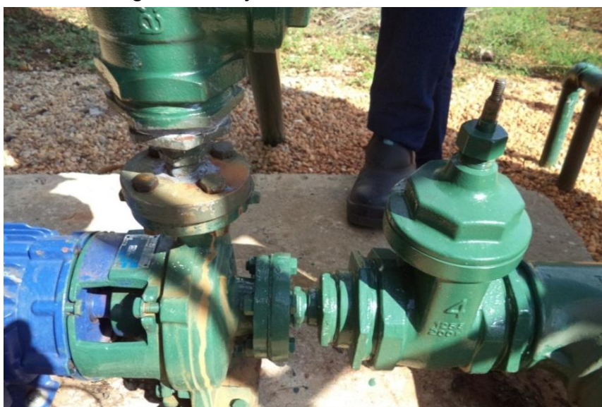
Figura 54. Conjunto motor bomba REL 001
