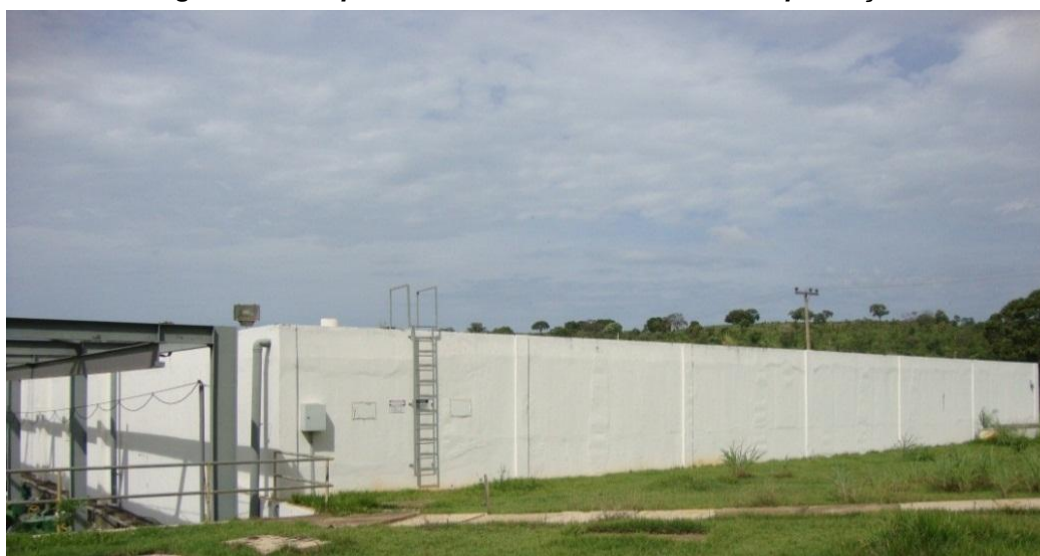
Figura 28. Tanque de contato/Reservatório de compensação
