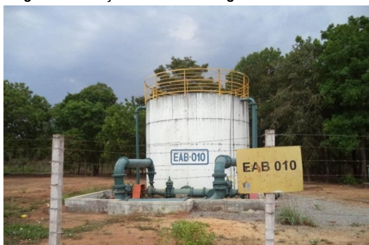
Figura 47. Estação Elevatória de Água Bruta – EEAB 010
