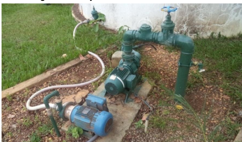
Figura 61. Conjunto motor bomba – EEAT 002
