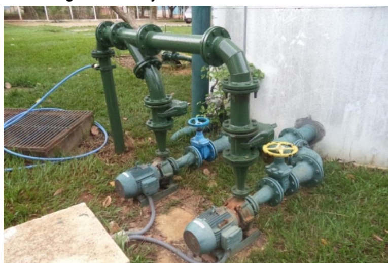
Figura 60 - Conjunto Motor-Bomba EEAT 001
