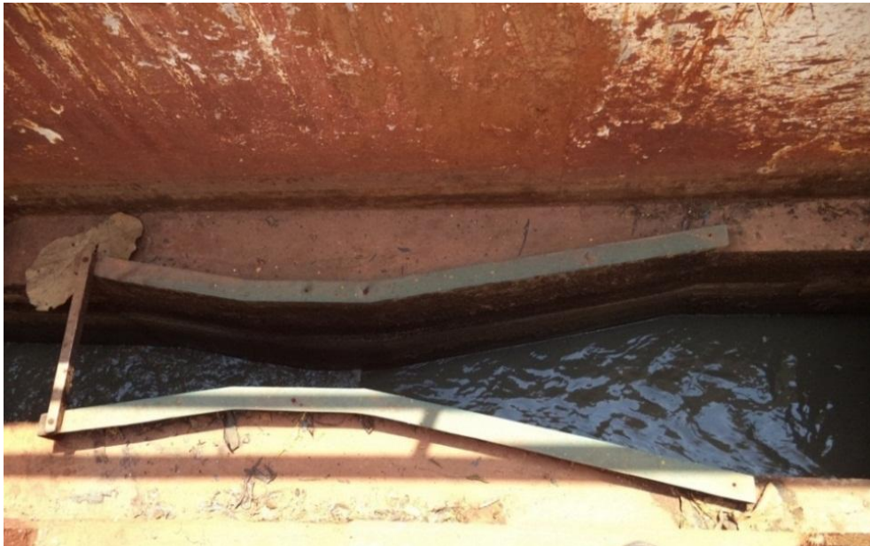
Figura 69. Calha Parshall de entrada
