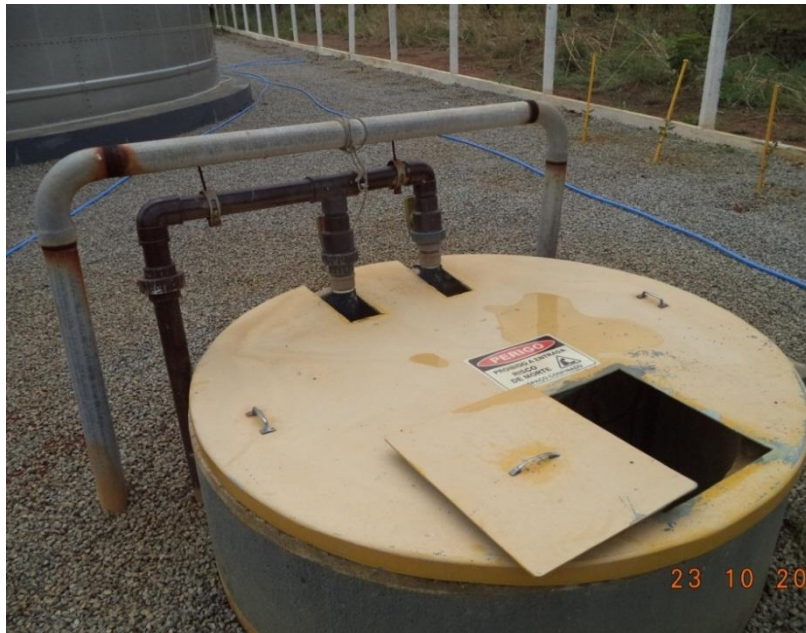
Figura 107. Poço de sucção - EEE Final
