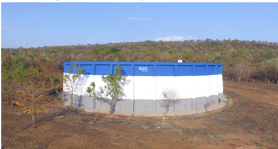
Figura 43. Reservatório Apoiado - RAP 002
