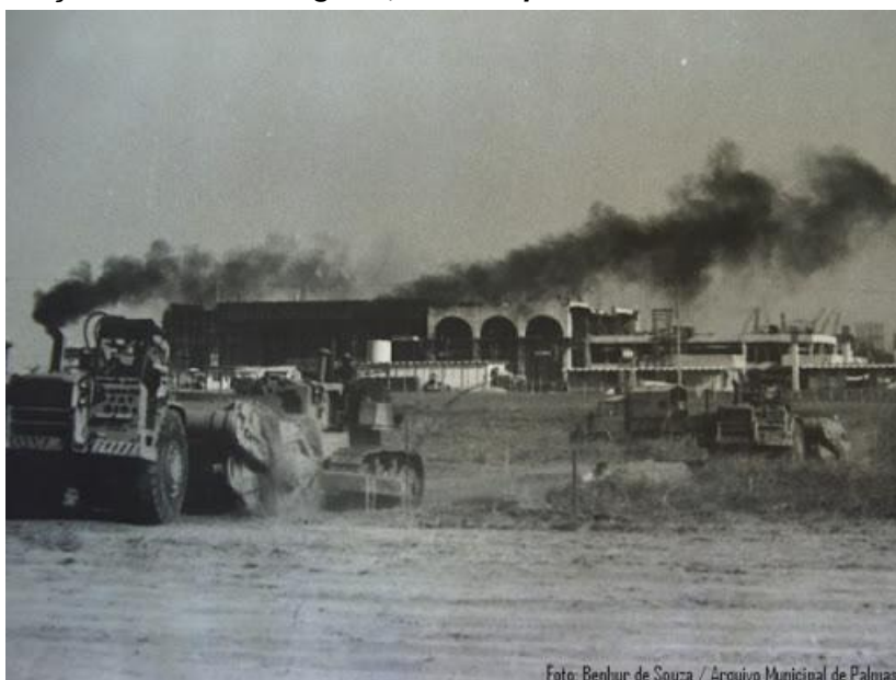
Figura 7. Construção do Palácio Araguaia, sede do poder executivo do estado do Tocantins
