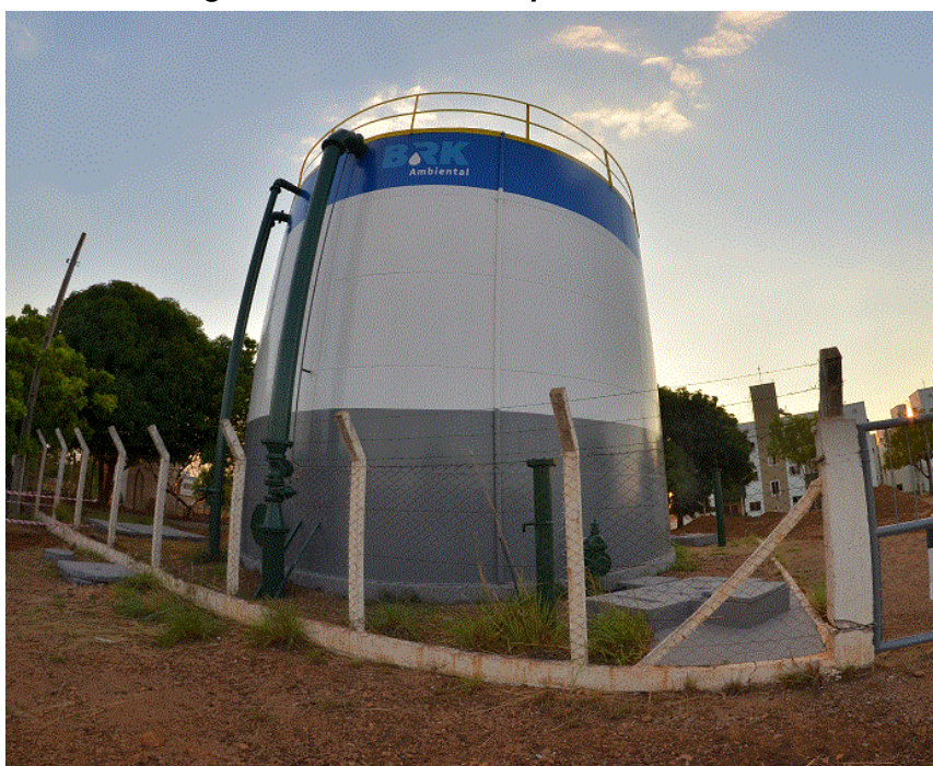
Figura 44. Reservatório Apoiado - RAP 006
