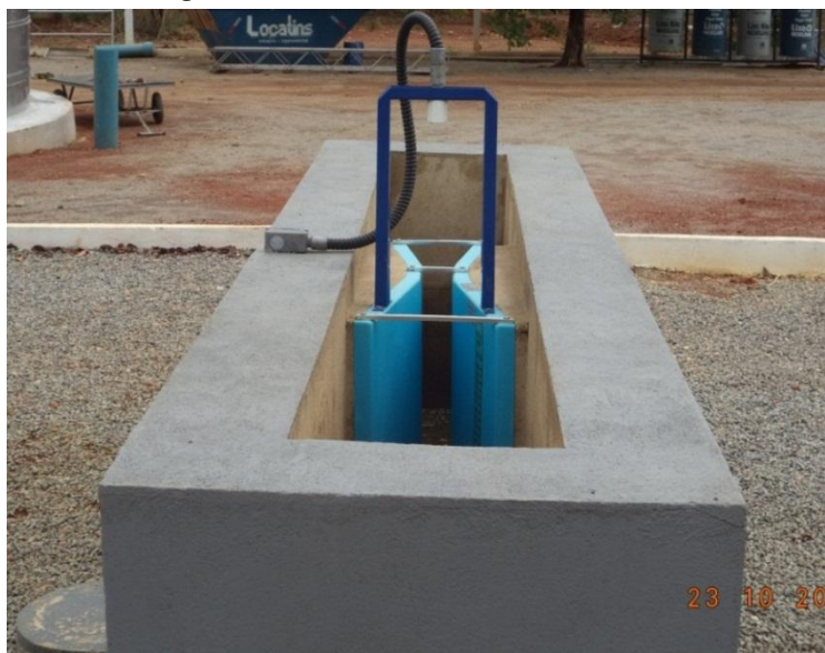
Figura 115. Calha Parshall de saída 6"
