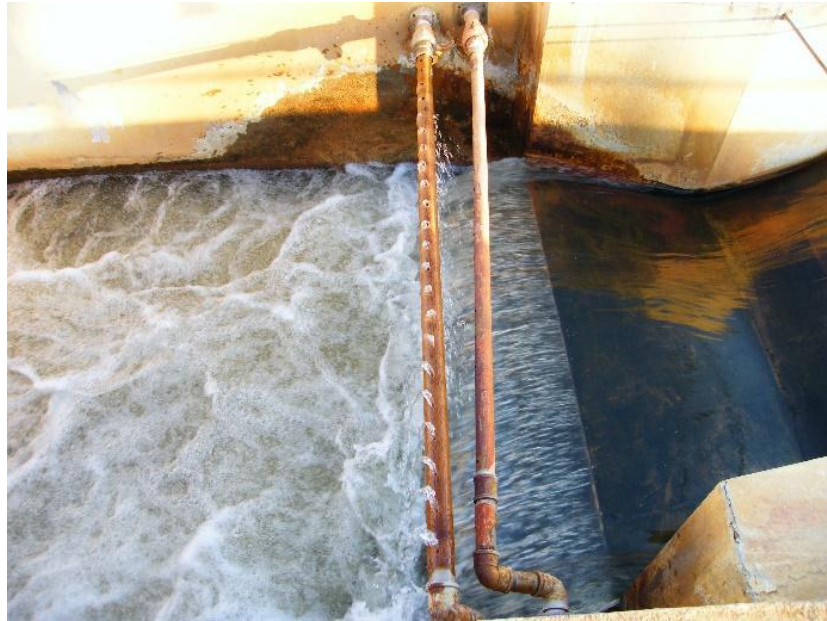
Figura 22. Calha Parshall
