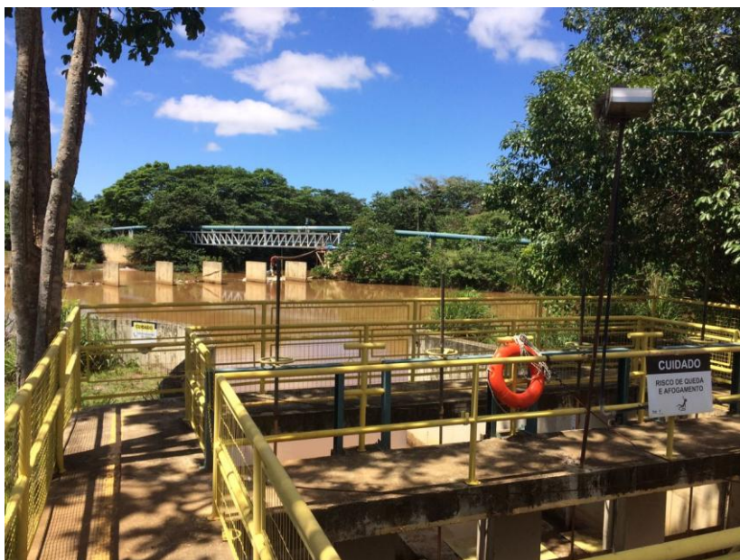
Figura 19. Captação de água bruta
