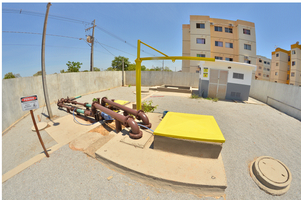
Figura 76. Estação Elevatória de Esgoto – EEE Flor do Cerrado – EEE 011
