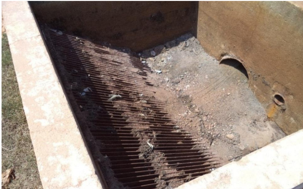
Figura 67. Caixa de gradeamento bruto para decantação
