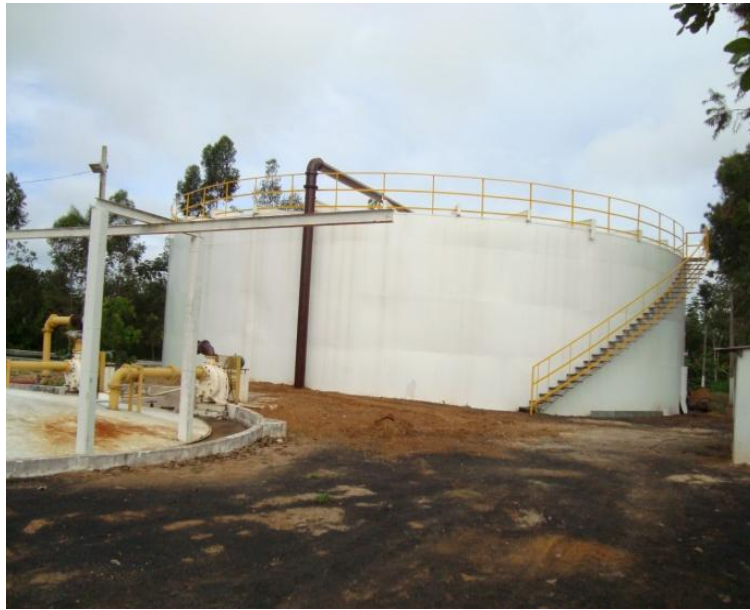
Figura 80. Reator UASB – ETE Prata
