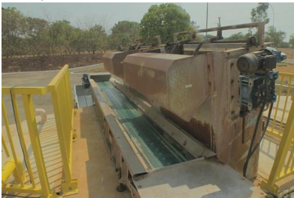
Figura 89. Gradeamento com esteira mecanizada com motor
