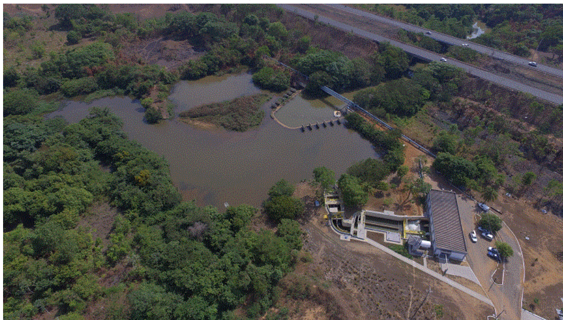
Figura 18. Captação no Ribeirão Taquarussu
