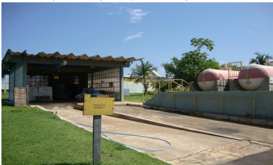
Figura 27. Abrigo e tanques armazenagem do cloro
