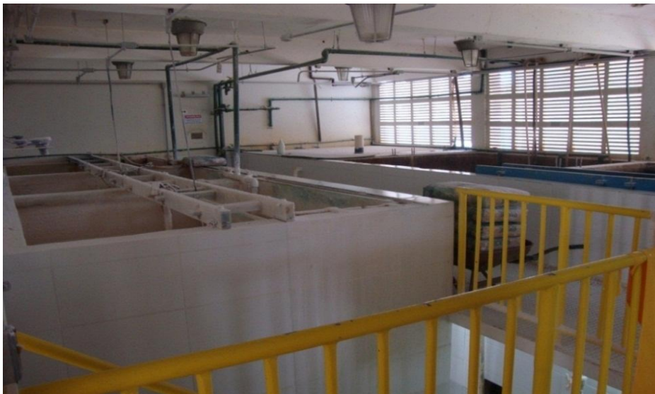
Figura 26. Depósito de produtos químicos
