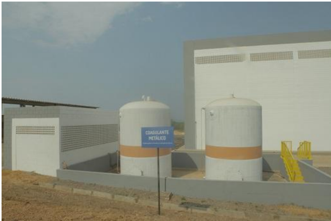
Figura 98. Tanques de produtos químicos
