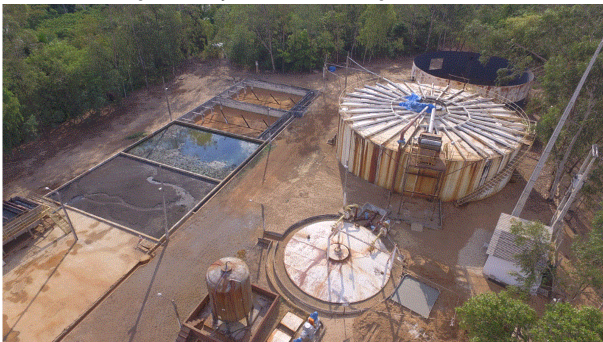
Figura 78. Estação de Tratamento de Esgoto – ETE Prata
