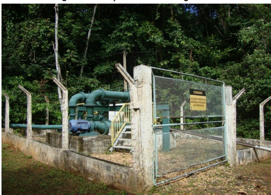
Figura 35. Estação elevatória de água bruta
