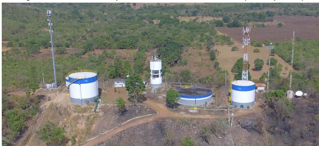
Figura 32. Reservatórios apoiados – RAP 003, 004, 010 e 019 ( CR Taquaralto)
