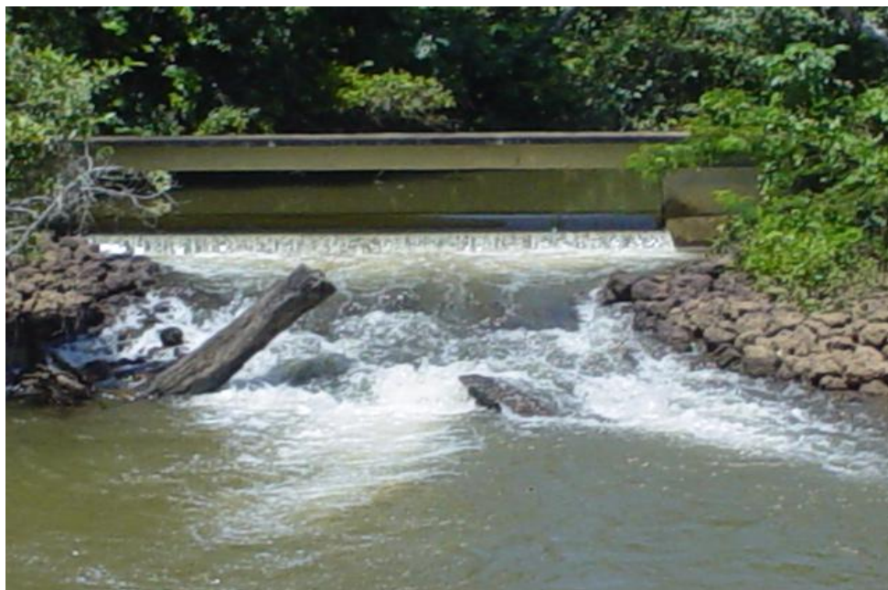
Figura 34. Local de captação ETA 003 – Sistema Água Fria
