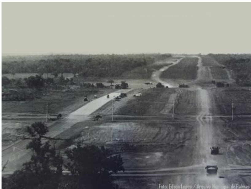
Figura 6. Processo de pavimentação das primeiras avenidas de Palmas
