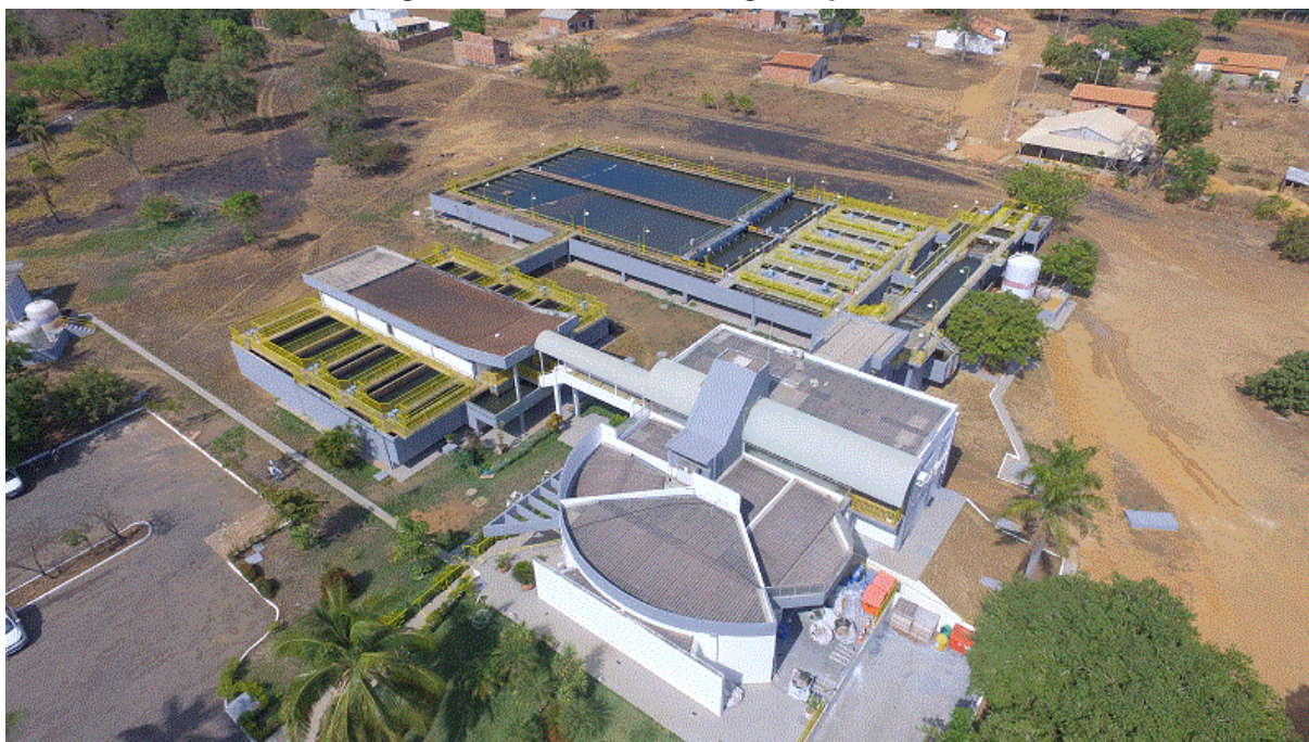
Figura 20. ETA 006 – Córrego Taquarussu
