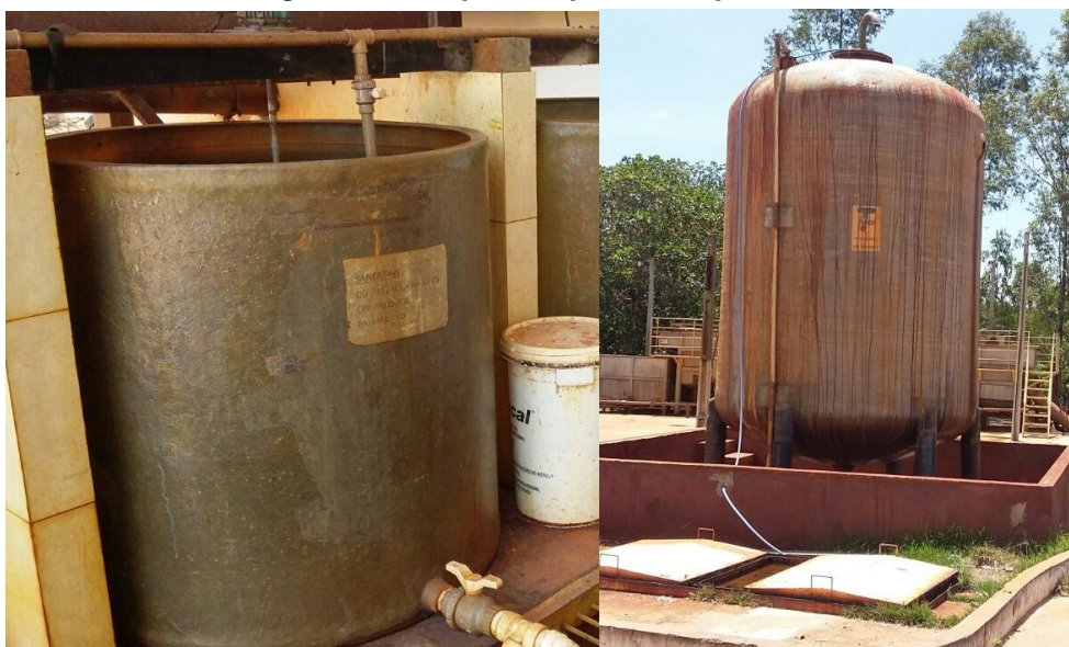
Figura 84. Tanques de produtos químicos
