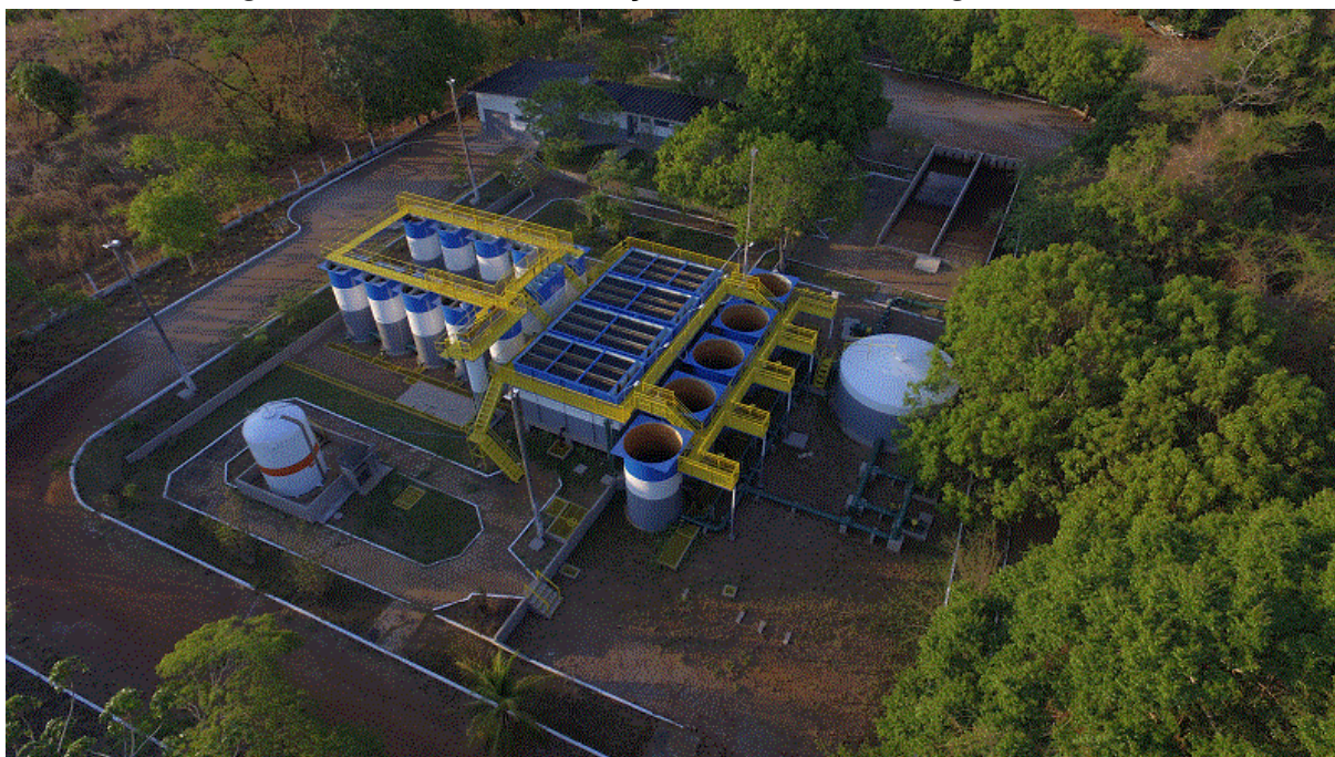
Figura 33. Vista aérea da estação de tratamento de água – ETA 03
