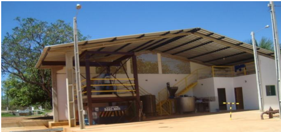
Figura 83. Casa do operador/ casa de produtos químicos/centrifuga
