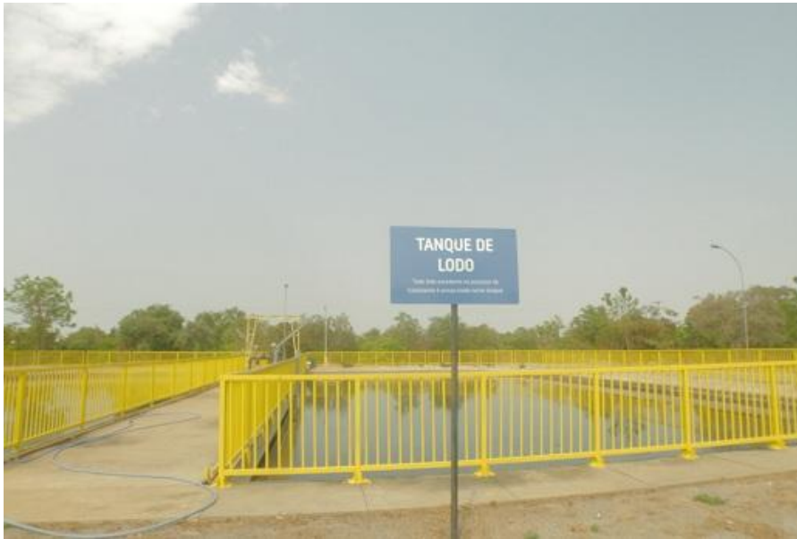
Figura 95. Tanque de lodo
