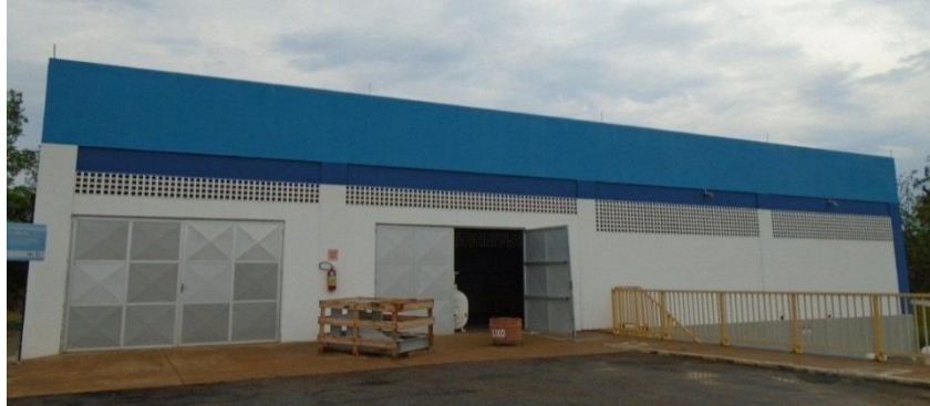
Figura 97. Sopradores e tratamento preliminar – Centro de controle de motores
