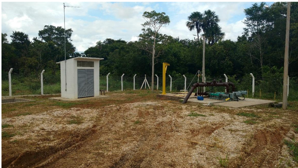
Figura 117. EEE - Santa Fé II – EEE 015
