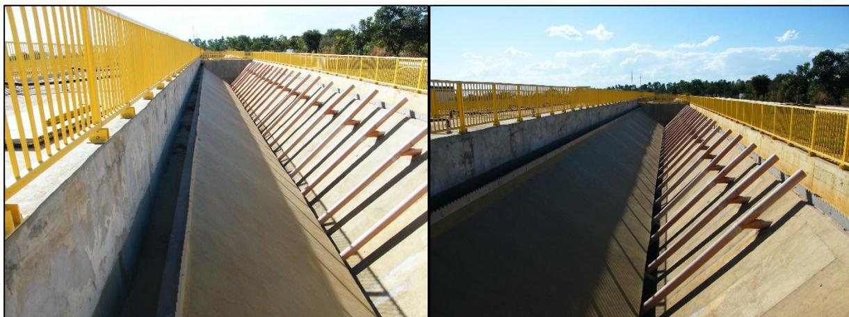
**Figura 0-LXXIV: Vista Interna dos Reatores UASB**
