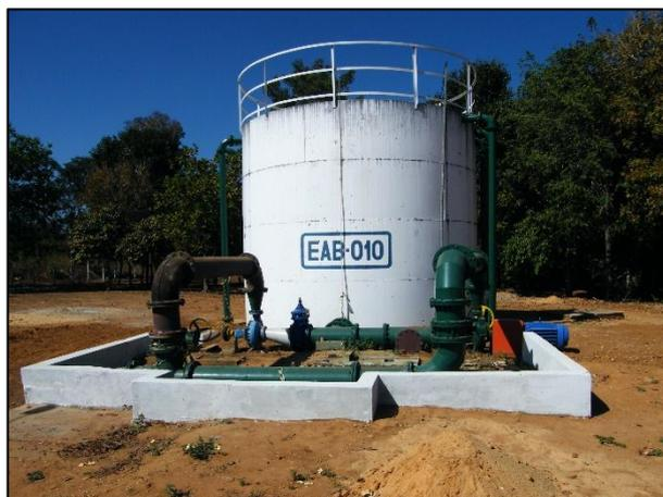
**Figura 0-XXXV: EEAB 010 – recalca água bruta a ETA 009**
