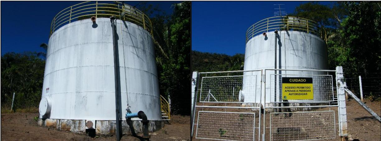
**Figura 0-XLVIII: RAP 018 – recebe água tratada da ETA 007 e distribui para a rede por gravidade**
