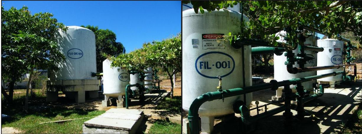
**Figura 0-XLII: Sistema de Tratamento ETA 006 em Taquaruçu - Floco-decantação e Filtros percoladores**
