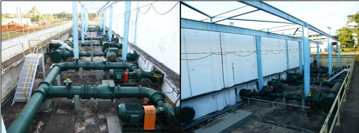
**Figura 0-XIII: Elevatória de Água Tratada**
