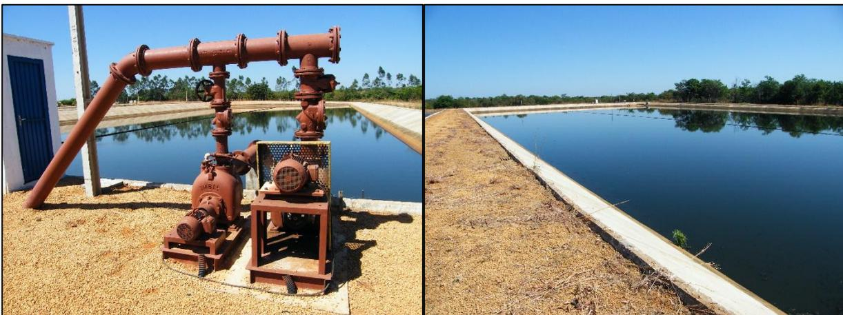
**Figura 0-LXI: Lagoa de maturação e recalque do efluentes tratado**
