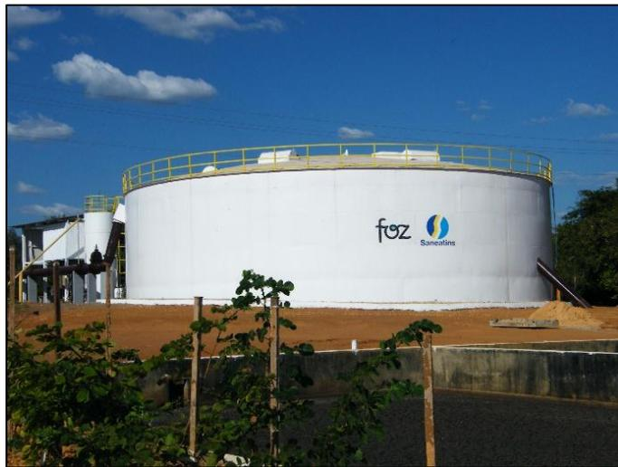
**Figura 0-LXX: Vista do Reator UASB**
