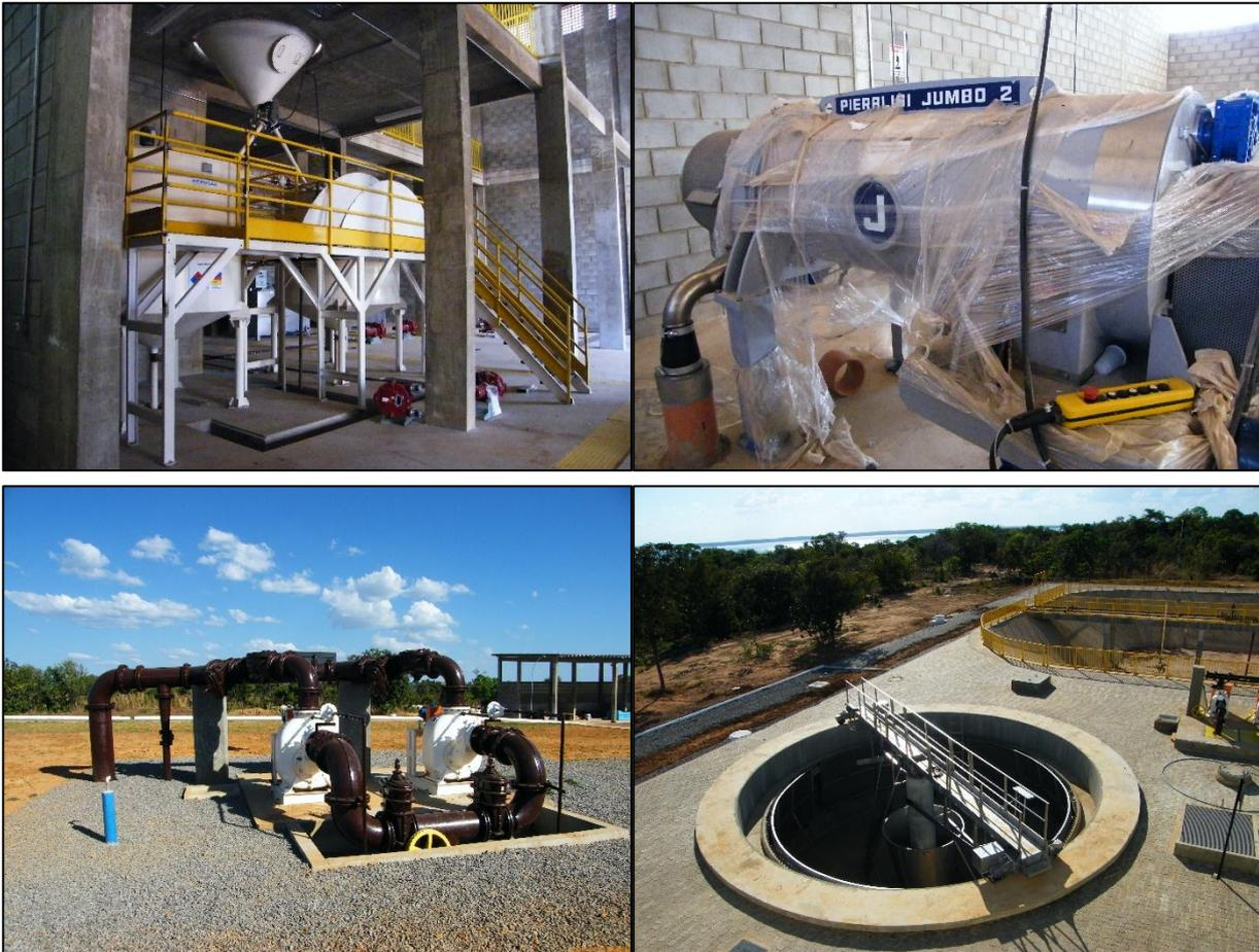
**Figura 0-LXXVII: Sistema de desidratção do lodo**
