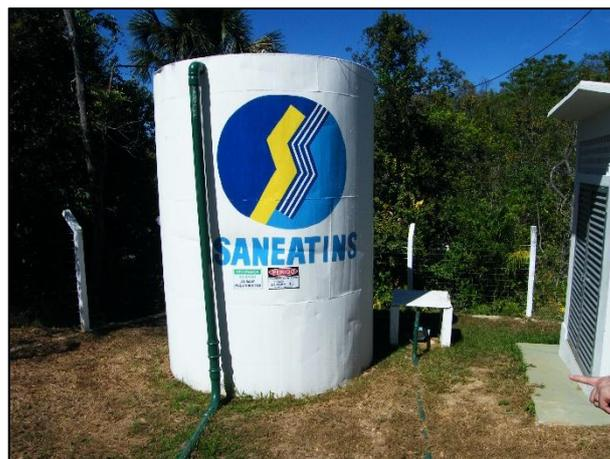
**Figura 0-LII: RAP 001 – recebe água das minas por gravidade e recalca para o REL 001**
