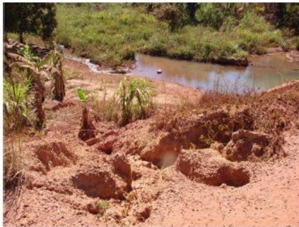
Foto 5: Assoreamento do Córrego Machado
