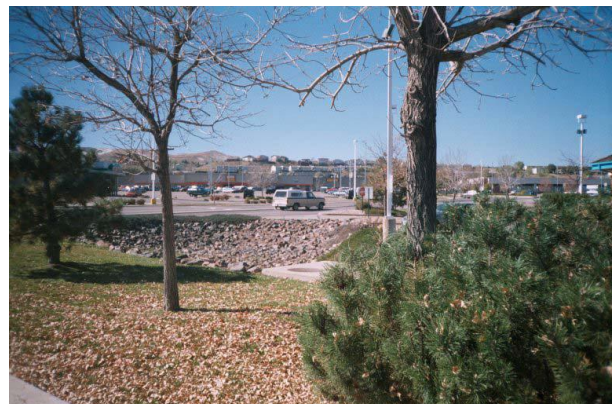
b- Detenções e Infiltrações
