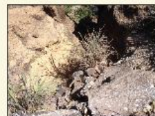
Foto 37 - Erosão em rocha do escoamento superficial.
