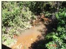
Foto 33 - Vista da ponte para jusante.
