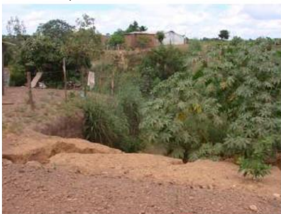
Foto 1: Processo Erosivo - Lote
