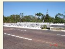
Foto 34 - Ponte da travessia com a NS-2.
