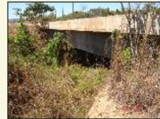
Foto 41 - Ponte na travessia da LO-6.
