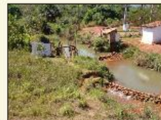
Foto 39 - Vista de montante - captações para irrigação.
