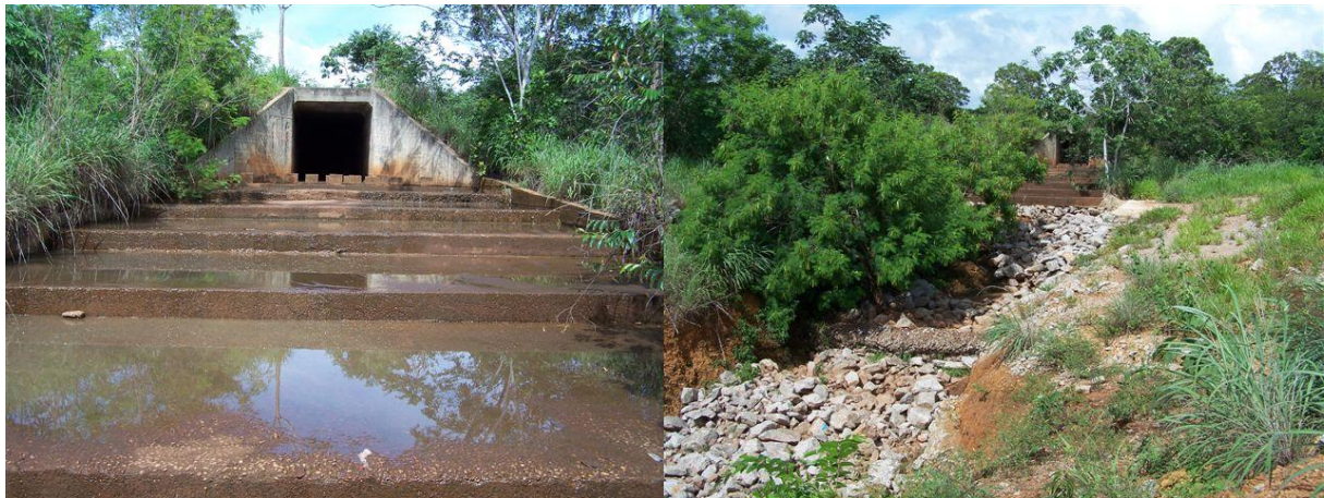
Figura 2.5-VII: Saída da galeria e desvio para o canal natural
