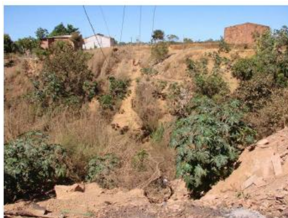
Foto 4: Erosão em encosta
