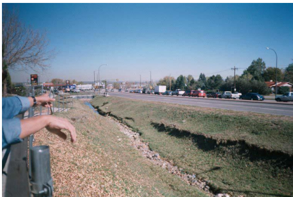
a- Detenções e Infiltrações
