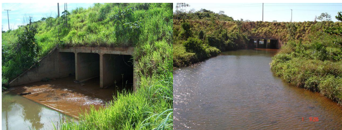
Figura 2.5-V: Galeria de Travessia sob a NS-10 (Entrada e Saída)
