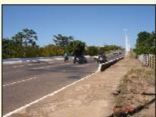
Foto 35 - Vista da Ponte.
