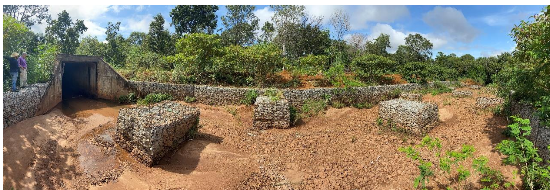
Vista Panorâmica da estrutura
