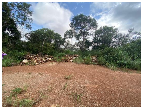
Entulho/Lixo acumulado no acesso ao Ponto de Lançamento
