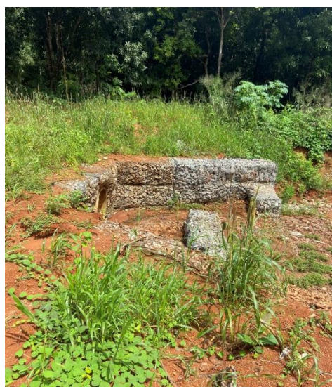
Dispositivo de lançamento com estrutura de Gabiões
