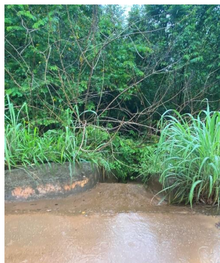
Descarga de drenagem superficial da via.
