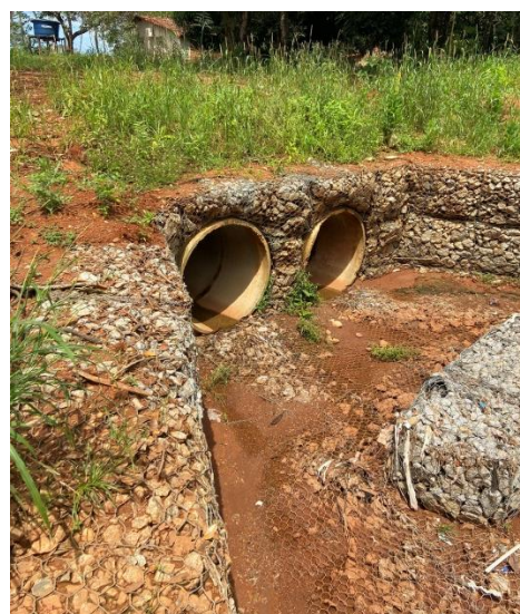
Dispositivo de lançamento com estrutura de Gabiões
