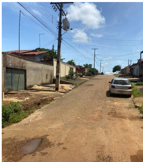
Pavimentação sem guias nem bueiros
