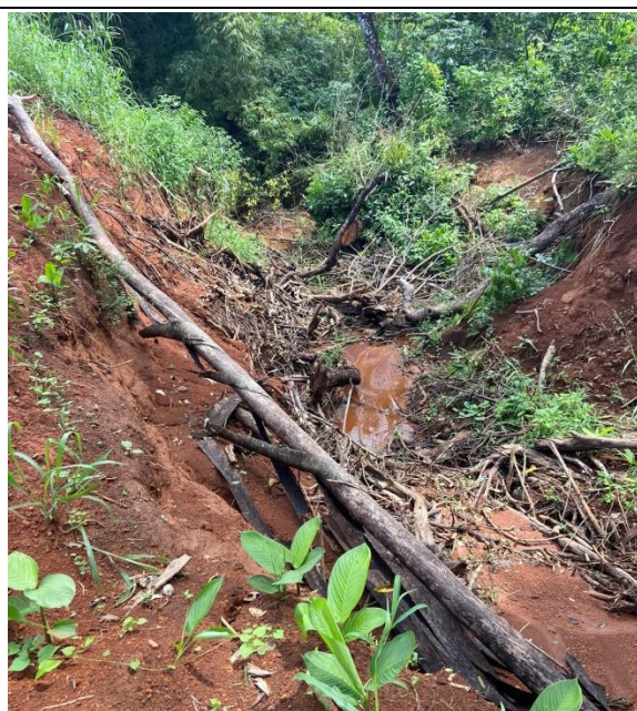
Erosão, resultado de enxurradas.
