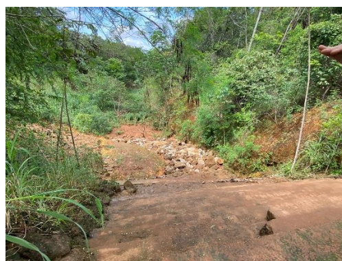
Altas vazões e velocidade de escoamento ocasionando carreamento de pedregulhos
