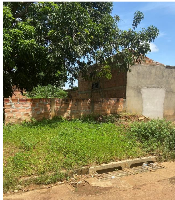
Fundo de vale (Córrego Machado) e Bocas-de-Lobo insuficientes para coletar a vazão das chuvas intensas
