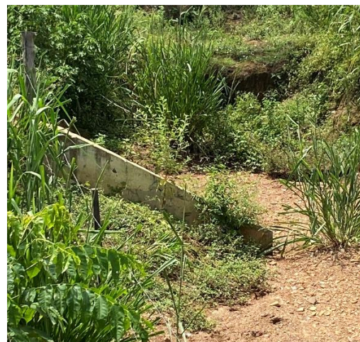
Emboque da tubulação de drenagem, observa-se assoreamento.
