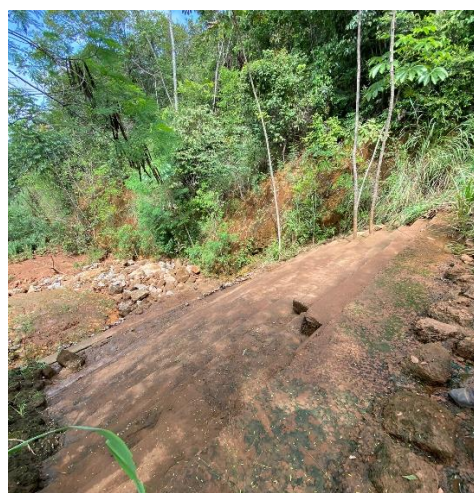
Estrutura de dissipação de energia (escada hidráulica) em boas condições
