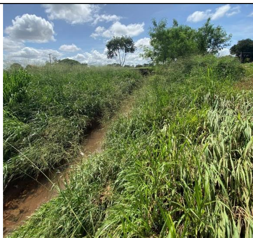
Canal de drenagem (vista à montante)
