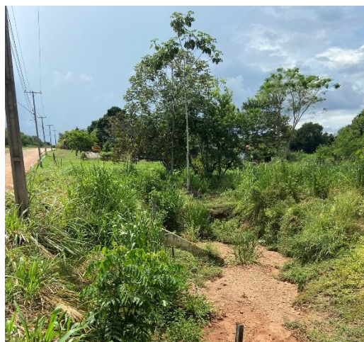
Emboque da tubulação de drenagem, observa-se assoreamento.
