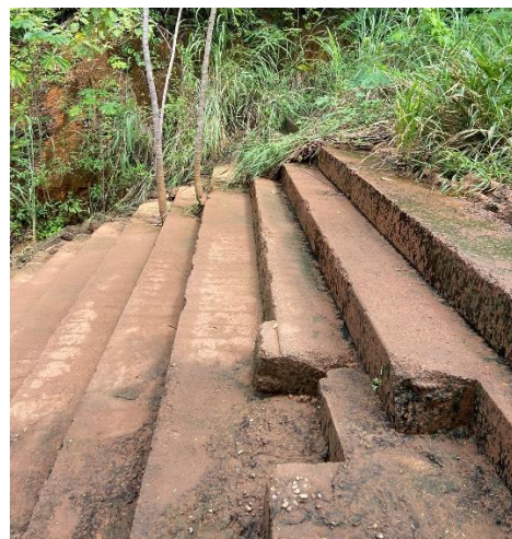
Estrutura de dissipação de energia (escada hidráulica) em boas condições
