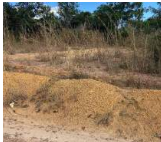
Acesso das águas à valeta ineficaz, obstruído pelo obstáculo de terra ao longo da via não pavimentada.
