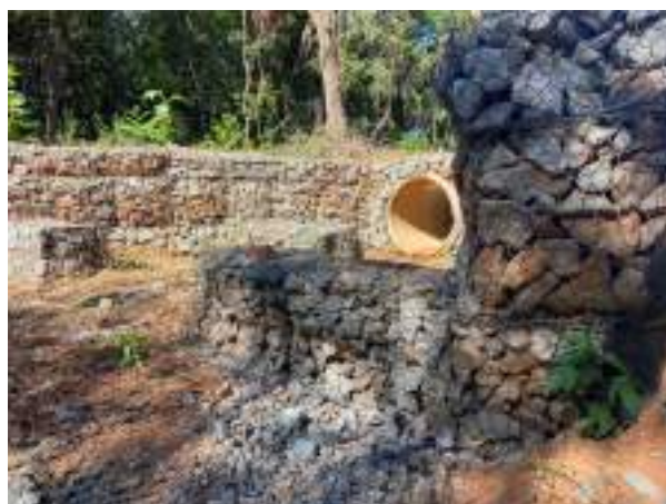
Estrutura aparentemente íntegra, funcional
