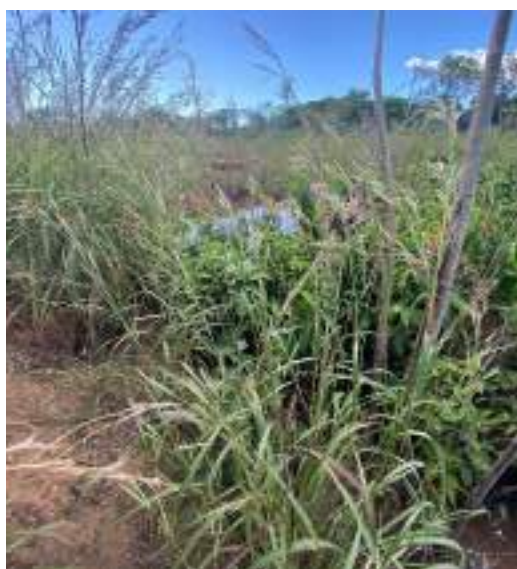
Vista à jusante da descarga da rede, vegetação impede adequado escoamento
