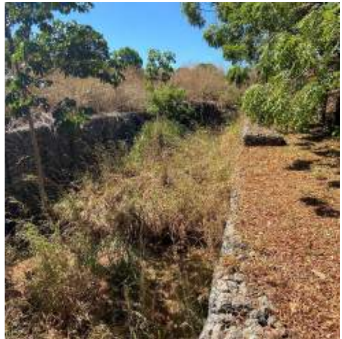
Infestação vegetal ao longo da estrutura-guia, à jusante do desemboque da rede de drenagem
