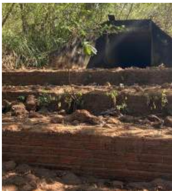
Desemboque da rede em escada hidráulica
