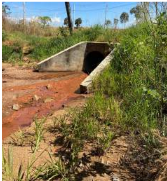
Solo imediatamente à jusante da descarga denota velocidades e energia mais elevadas que o desejável
