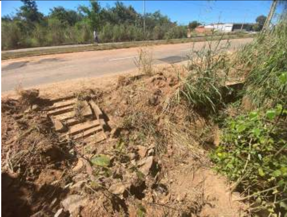
Vista geral do Ponto de Lançamento da rede: escoamento superficial (esq.) e descarga de tubulação (dir.)
