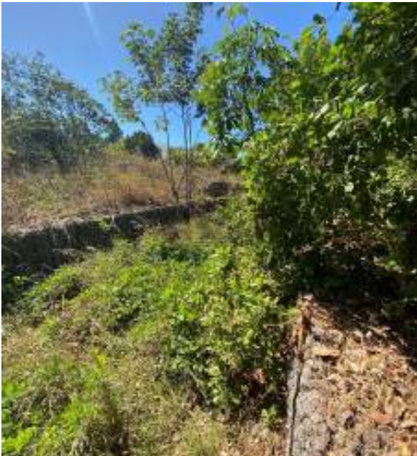
Infestação vegetal ao longo da estrutura-guia, à jusante do desemboque da rede de drenagem
