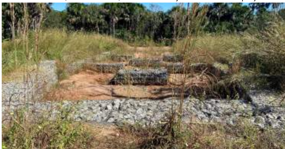
Vista da estrutura para jusante
