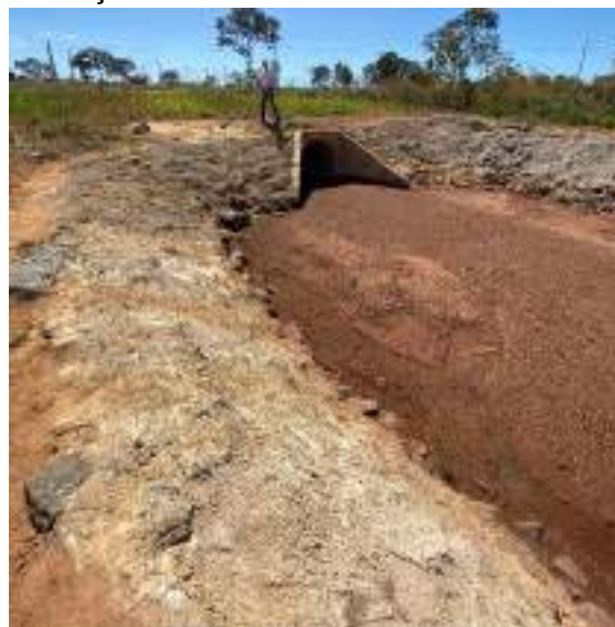
Estrutura de desemboque da rede de drenagem
