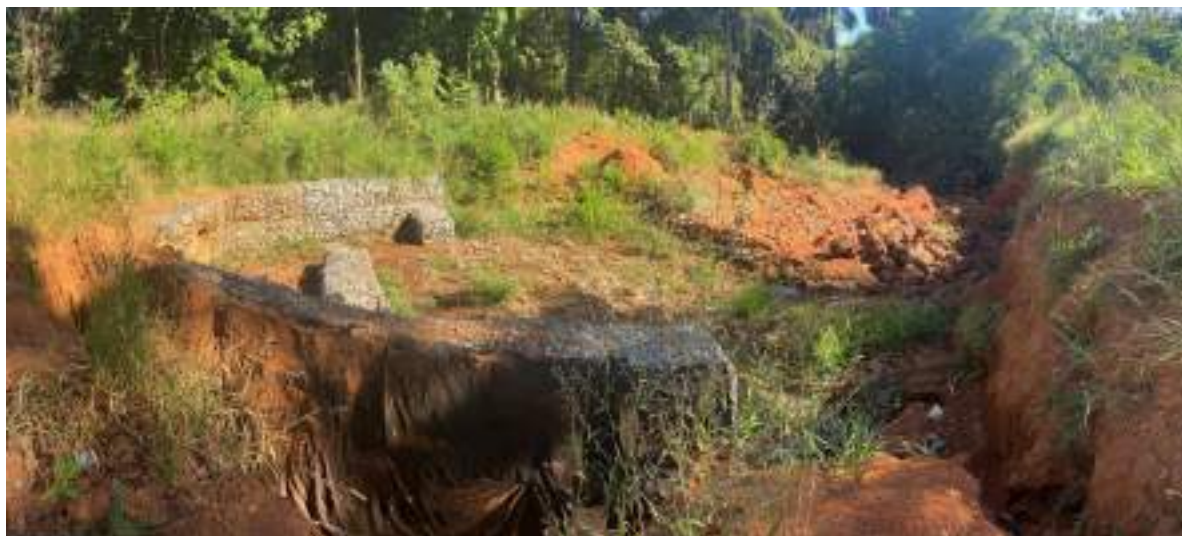
Visão geral do Ponto de Lançamento
