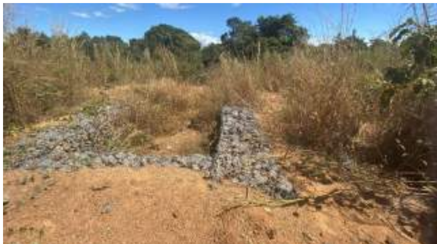
Vista para jusante do Ponto de Lançamento da rede de drenagem
