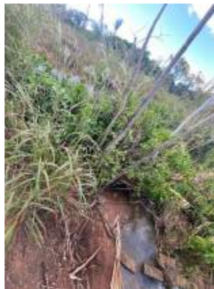
Vista à jusante da descarga da rede, vegetação impede adequado escoamento
