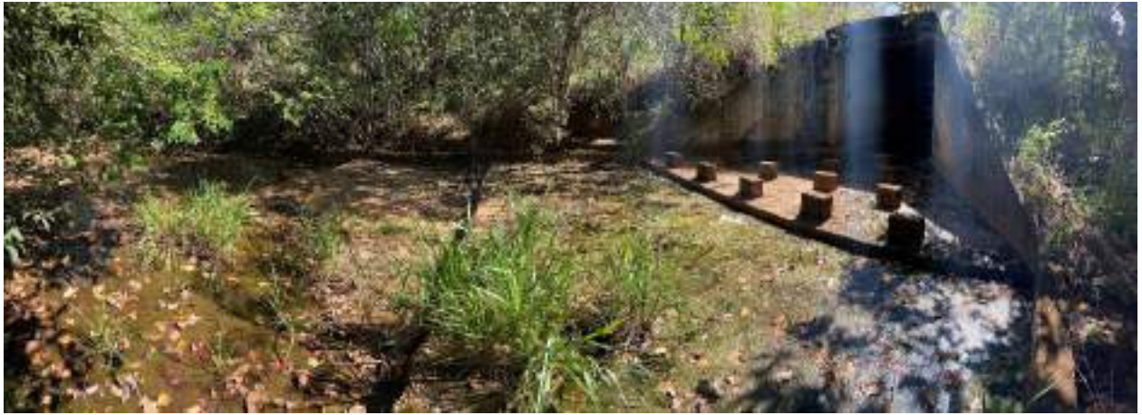
Visão geral do Ponto de Lançamento
