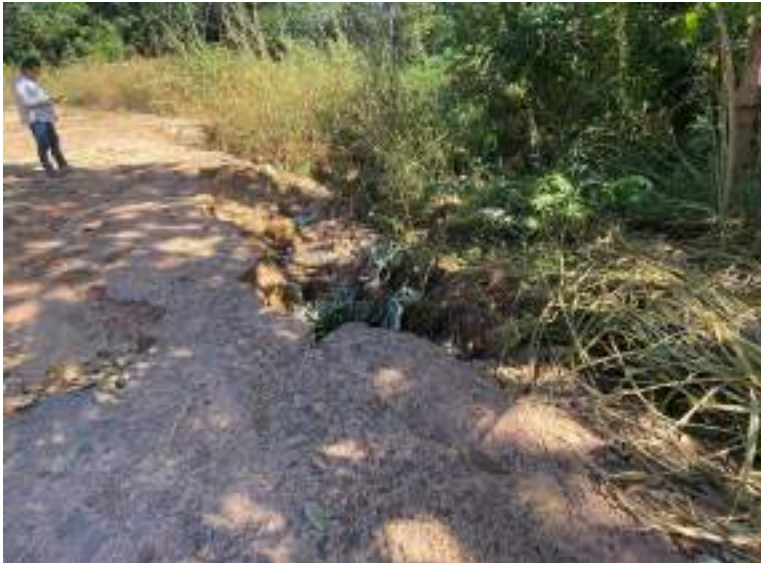
Pavimento colapsado na aproximação do local onde a rede de drenagem desemboca – não há guias nem calçamento
