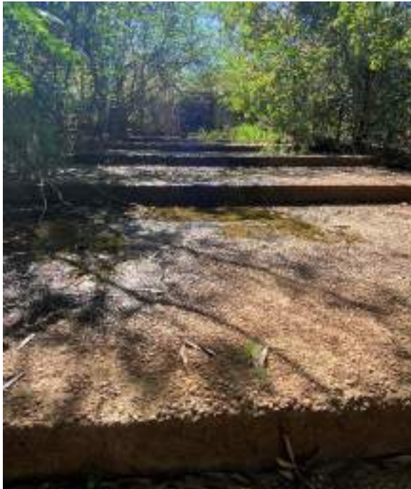
Estrutura em concreto, robusta, íntegra e funcional
