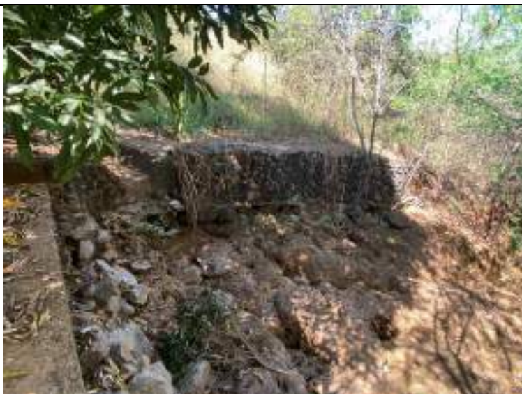
À jusante do ponto de lançamento, erosão observável ao longo do canal natural, no curso rumo ao talvegue principal
