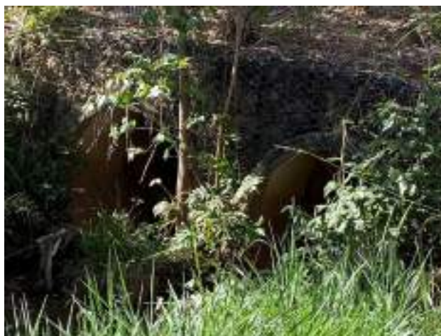
Desemboque da rede em área de retenção, 2 tubos de 1500mm
