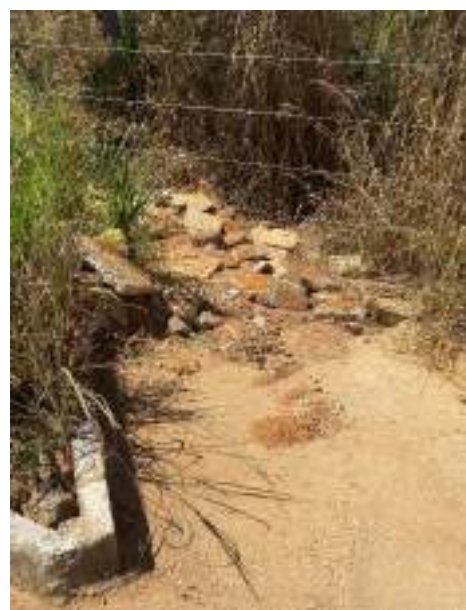
Pavimentação sem calçamento – o dispositivo de drenagem superficial já apresenta problemas
