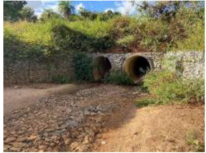
Estrutura em gabiões, funcionalidade perceptível devido ao aspecto geral do ponto de lançamento
