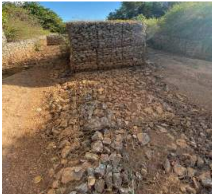
Malha da estrutura conservada, com assoreamento -nas laterais- por diminuição de velocidade de escoamento
