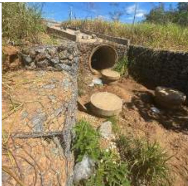
A descarga do desemboque da rede -tubo de 1500mm- ocorre em estrutura de transição de gabiões
