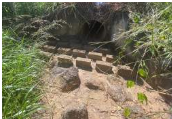
Desemboque em tubo único e dissipadores de energia
