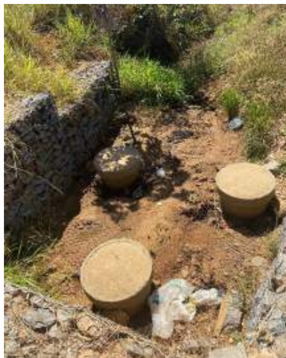
O extravasor tem alta declividade e queda de 1,5 m sobre a descarga da rede, em gabiões.
