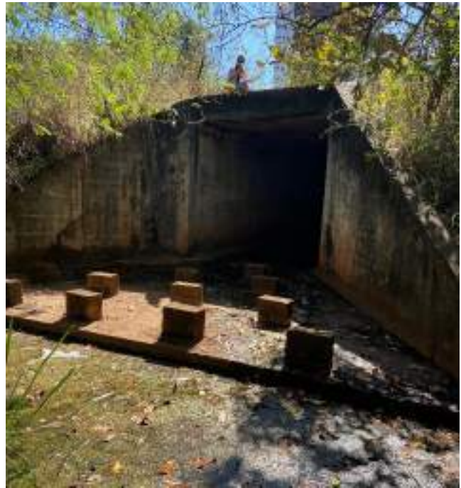
Galeria de 4x3 metros, incoberta por vegetação alta
