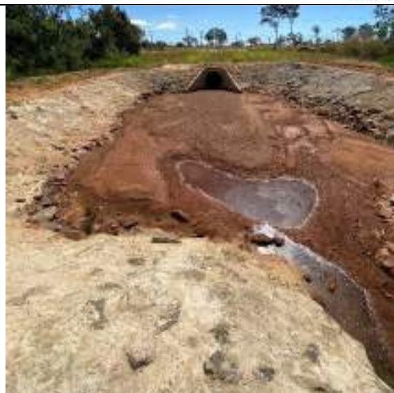
A bacia de retenção é boa estratégia para dissipar energia
