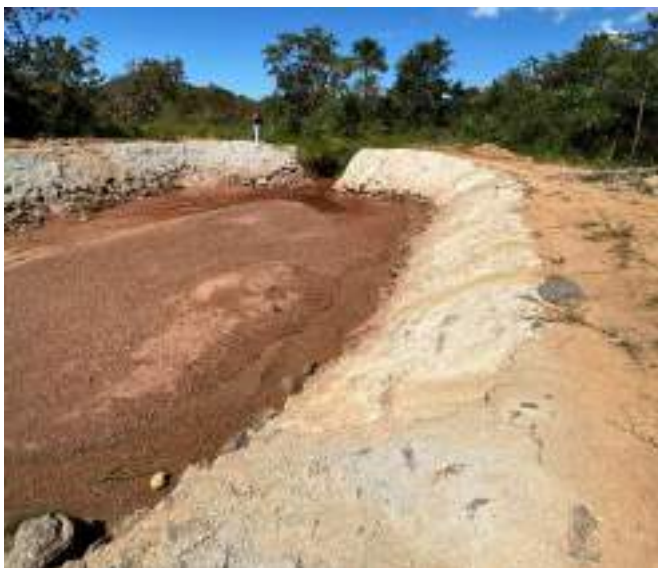
Para jusante: seção de escoamento para o canal à céu aberto
