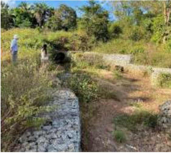
Estrutura em gabiões, funcionalidade perceptível devido ao aspecto geral do ponto de lançamento
