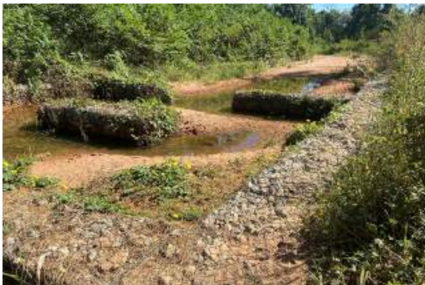
Estrutura em gabiões funcional – o visível assoreamento confirma redução de velocidade – e energia – do escoamento
