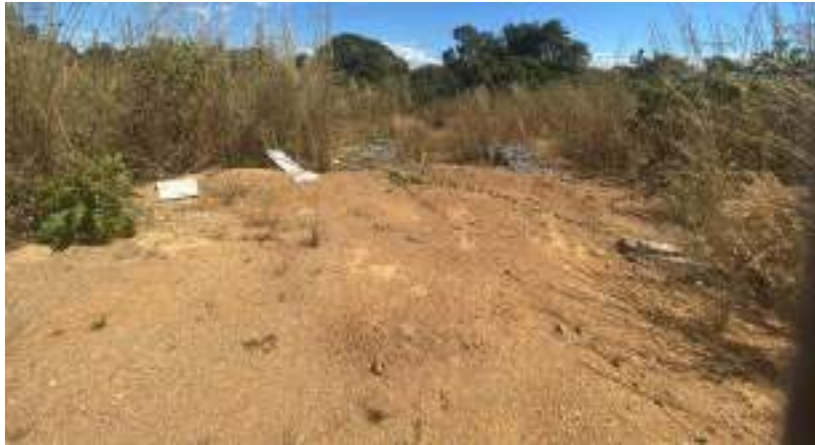
Vista da estrutura em Gabiões, a partir da rua. Nenhuma sinalização ou aviso de segurança
