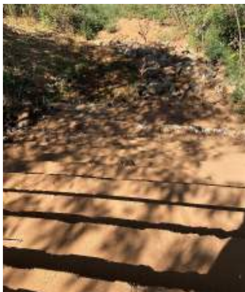
Segunda escada hidráulica à jusante da galeria
