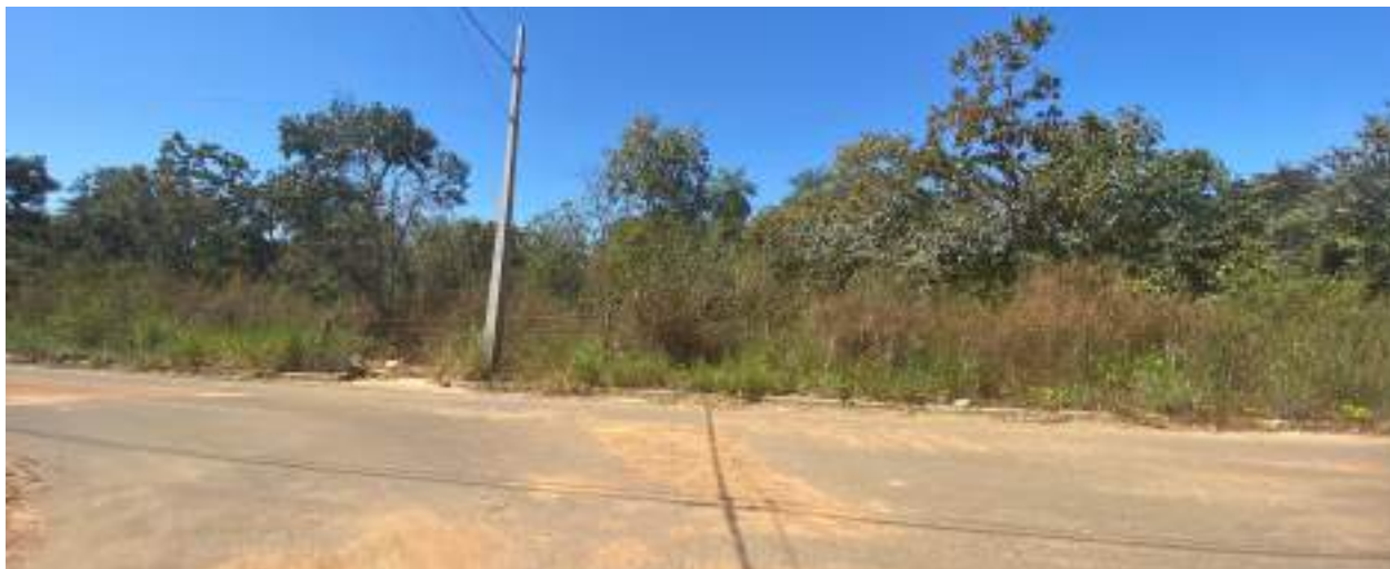
Visão Geral da Rua para o Ponto de Descarga (superficial)- não há calçamento
