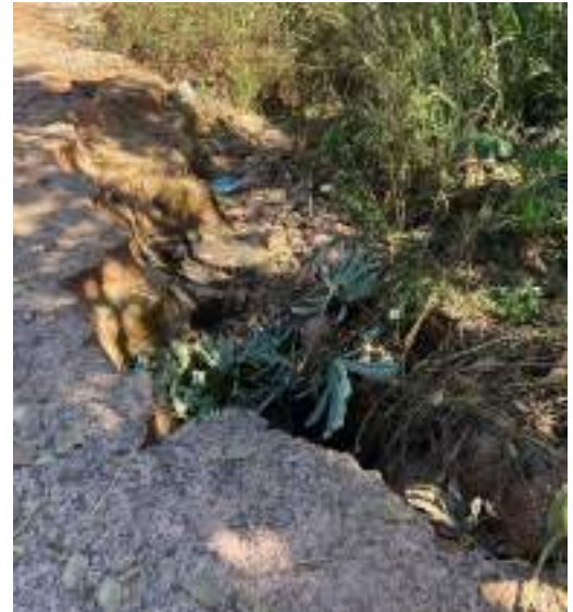
Pavimento colapsado na aproximação do local onde a rede de drenagem desemboca – não há guias nem calçamento
