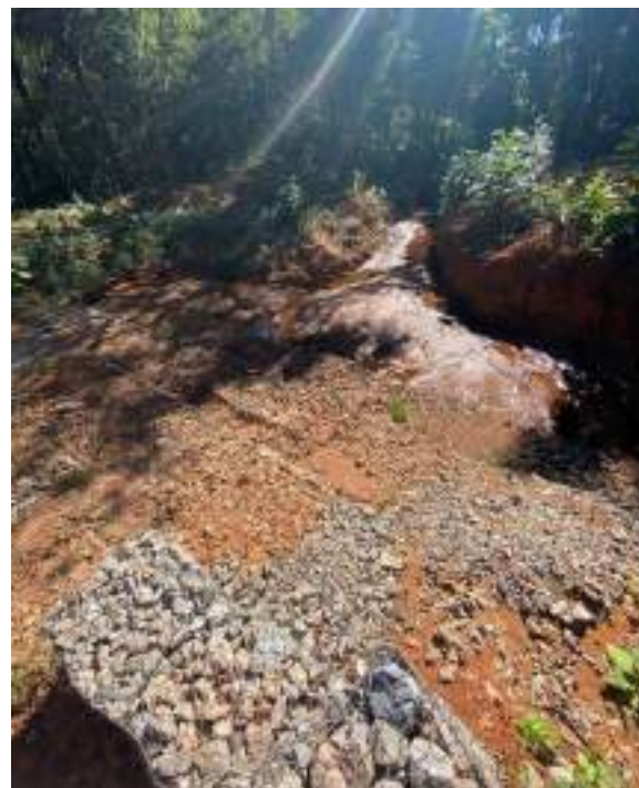
Vista à jusante da estrutura, canal natural estreito
