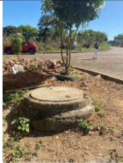
Poço de inspeção da rede de drenagem
