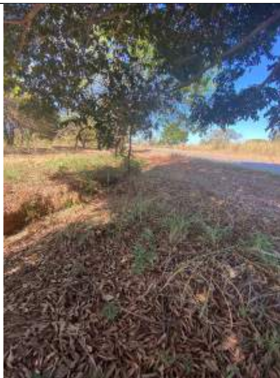
Vala de escoamento formada por enxurradas – processo erosivo em andamento
