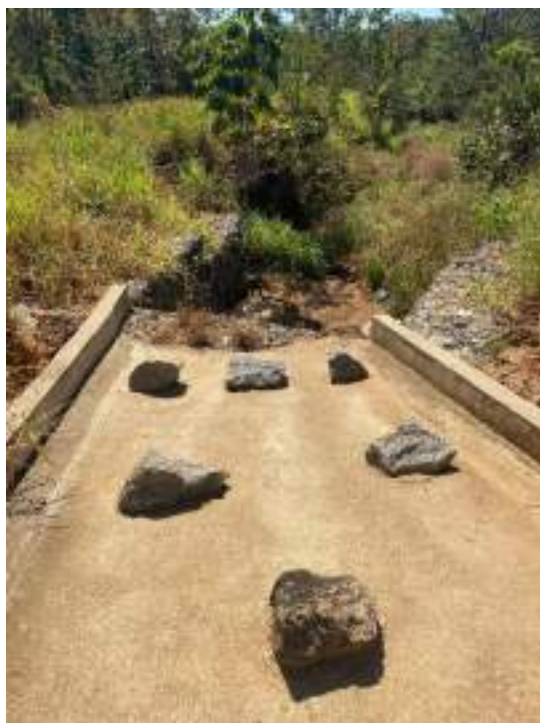
O extravasor tem alta declividade e queda de 1,5 m sobre a descarga da rede, em gabiões.
