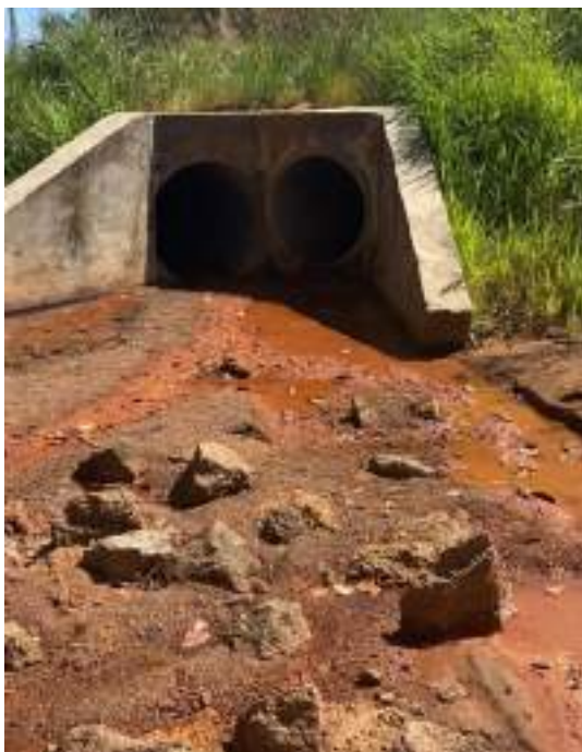
Solo imediatamente à jusante da descarga denota velocidades e energia mais elevadas que o desejável
