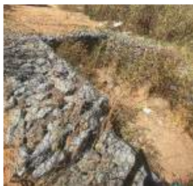
Detalhe da ala em gabião
