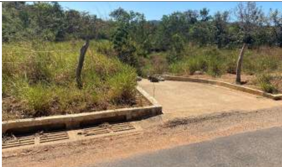
Vista da rua: bocas de lobo e extravasor superficial
