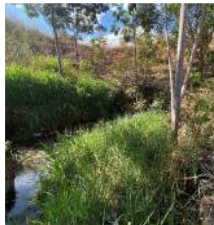
Pequena estrutura de gabiões e retenção
