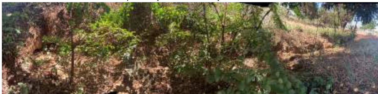
Vista em 270°: desde a pista (dir.), vala do escoamento até o tubo de passagem (esq.)
