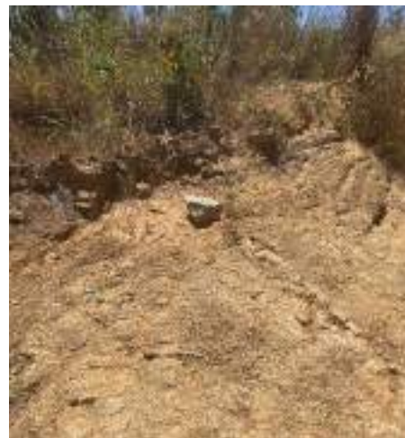
Condição do solo imediatamente à jusante da estrutura de Gabiões – claro caminho de vertimento
