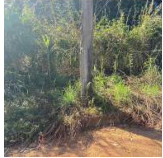
Observa-se no poste altura -aprox. 1m- das águas de enxurradas no local
