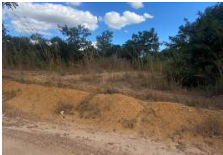
Acesso das águas à valeta ineficaz, obstruído pelo obstáculo de terra ao longo da via não pavimentada.
