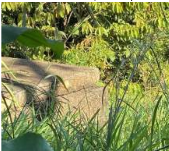
Caixas de passagem e inspeção infestadas por vegetação - localizadas antes da descarga da rede, que não está acessível
