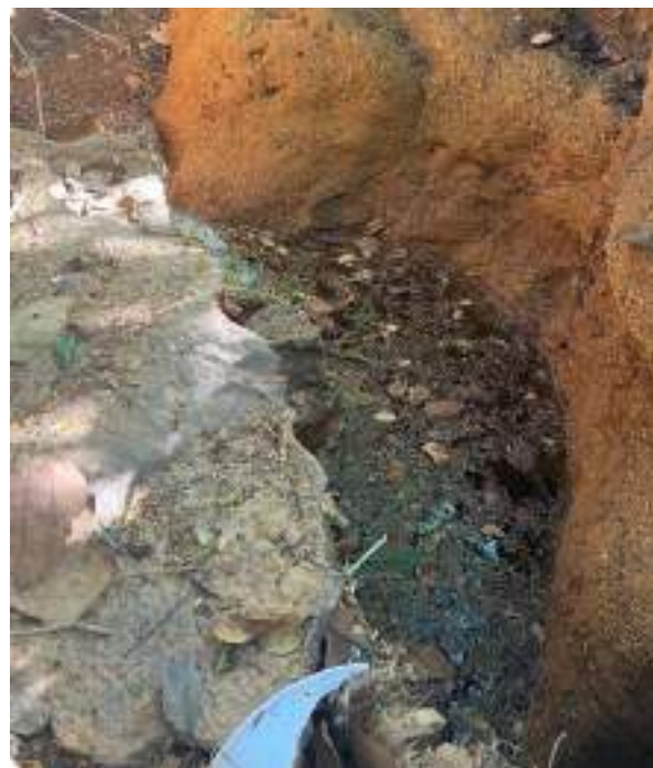
Profundidade significativa das fendas resultantes da erosão
