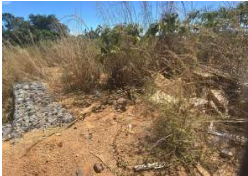
Observa-se à direita, lixo e entulho descartados de forma inadequada
