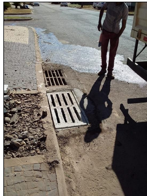
Desobstrução da caixa receptora da boca de lobo e substituição da grelha
