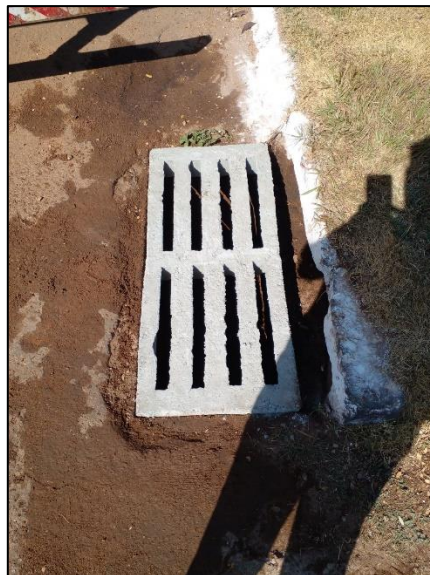
Desobstrução e troca de grelha de boca de lobo
