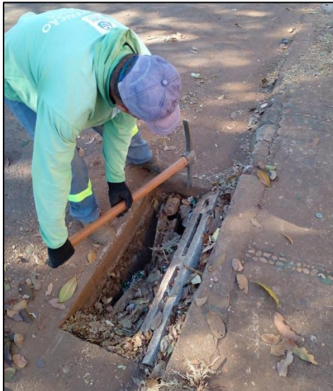
Substituição de grelha danificada
