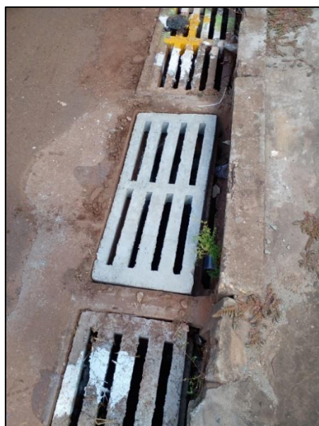
A posição das caixas das bocas de lobo, fora do calçamento, e na faixa direita de rodagem ocasiona frequentes rupturas pelo tráfego de automóveis.
