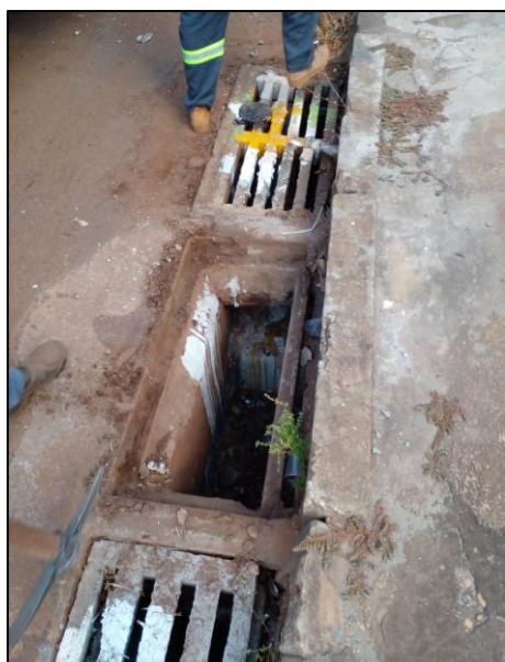
A posição das caixas das bocas de lobo, fora do calçamento, e na faixa direita de rodagem ocasiona frequentes rupturas pelo tráfego de automóveis.
