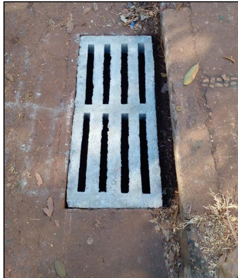
Substituição de grelha danificada
