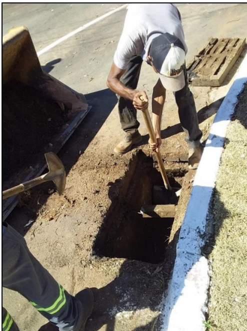
Desentupimento de Boca de Lobo e reparo de grelha em rotatória. Comumente as grelhas de concreto localizadas em rotatórias da cidade são avariadas pelo tráfego dos automóveis
