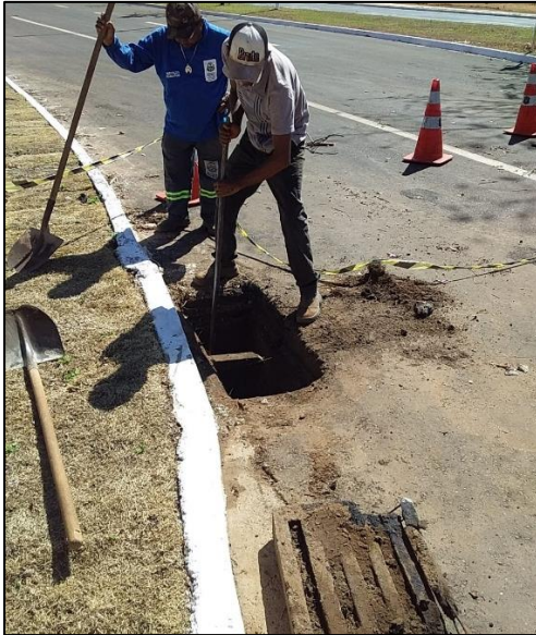
Troca de Grelha em faixa de rodagem, próximo à chegada em rotatória.
