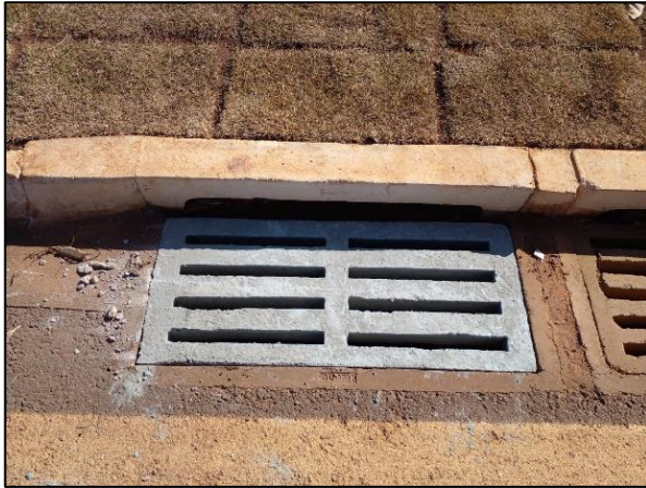
Nova grelha instalada
