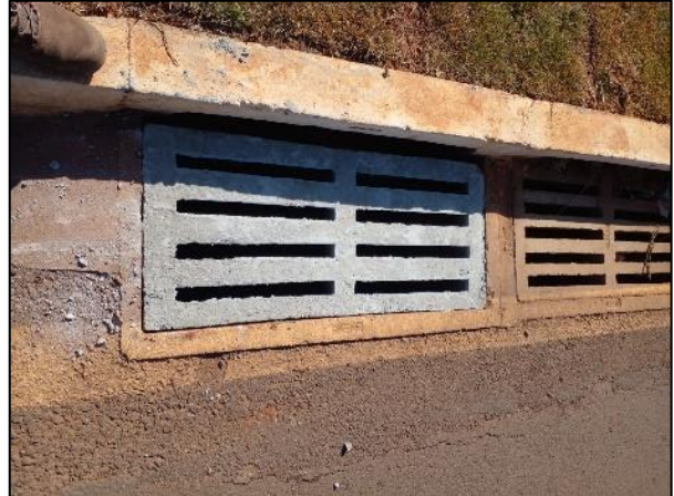
Nova grelha instalada
