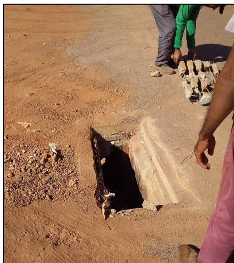
Boca de lobo mal posicionada, em intersecção de vias, fora da sarjeta/meio-fio: constante necessidade de substituição devido à ruptura grada pelo tráfego de automóveis.
