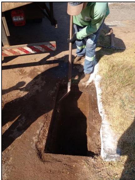
Desobstrução e troca de grelha de boca de lobo
