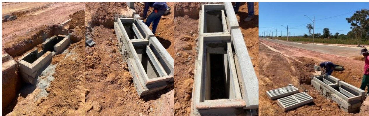
Figura A-IV-9: Obras no setor Morada do Sol - bocas de lobo e pavimentação.
