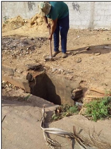
Reparo da caixa da boca de lobo e da respectiva grelha
