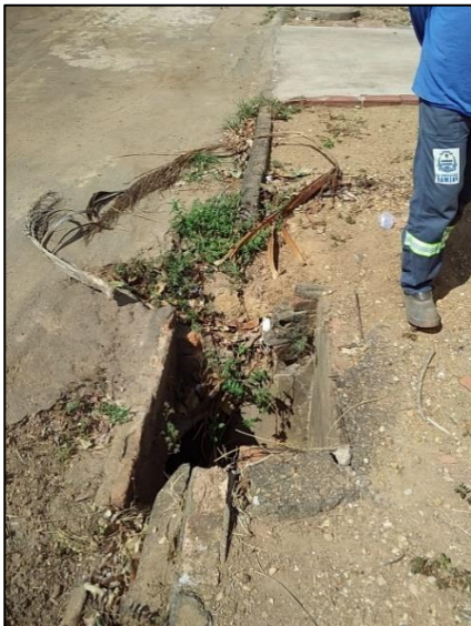
Reparo da caixa da boca de lobo e da respectiva grelha
