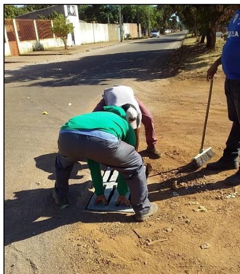
Boca de lobo mal posicionada, em intersecção de vias, fora da sarjeta/meio-fio: constante necessidade de substituição devido à ruptura grada pelo tráfego de automóveis.
