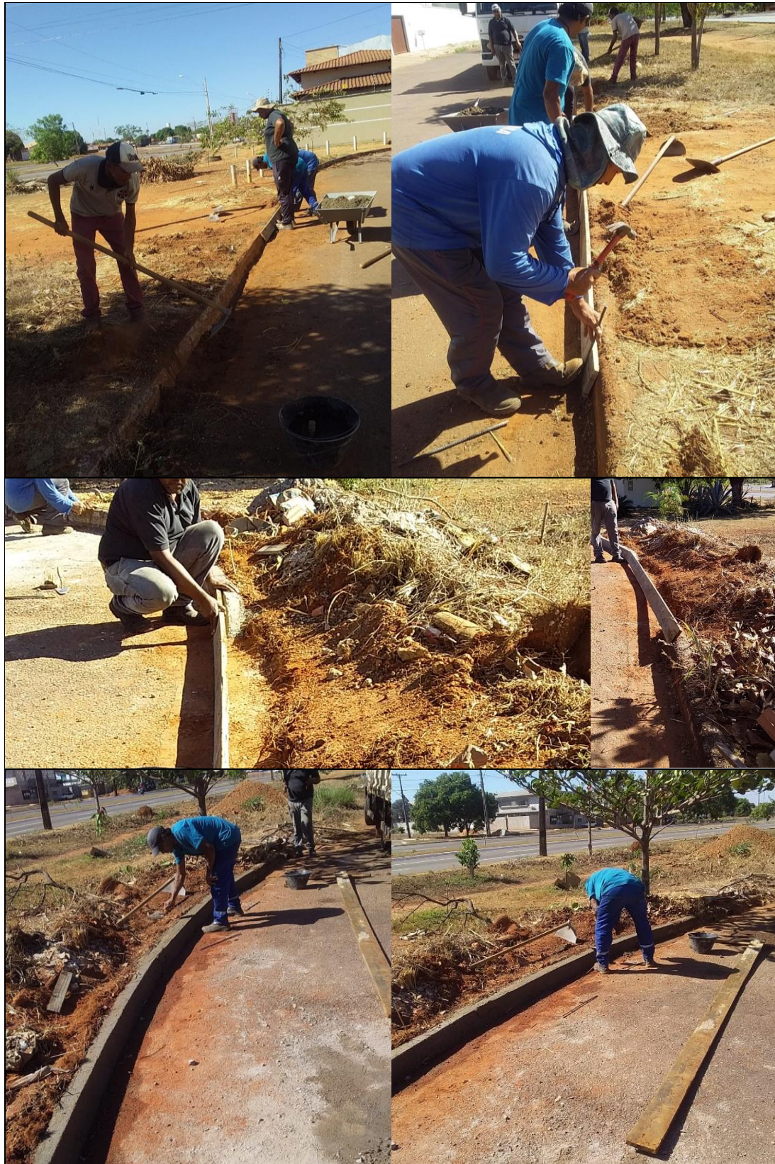
Figura A-IV-8: Serviço de reparo e reenquadramento de canteiro e meio-fio
