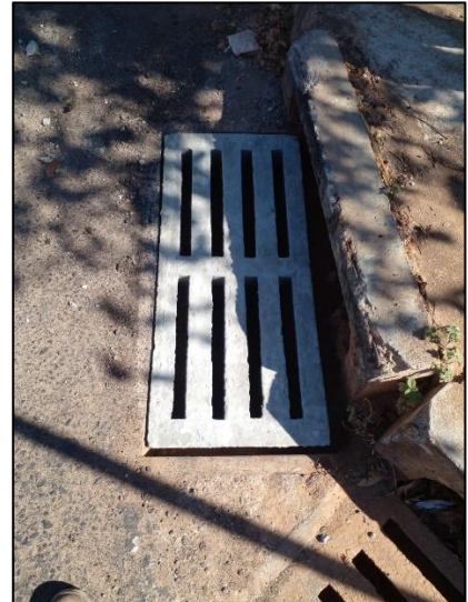
Reparo da caixa da boca de lobo e da respectiva grelha
