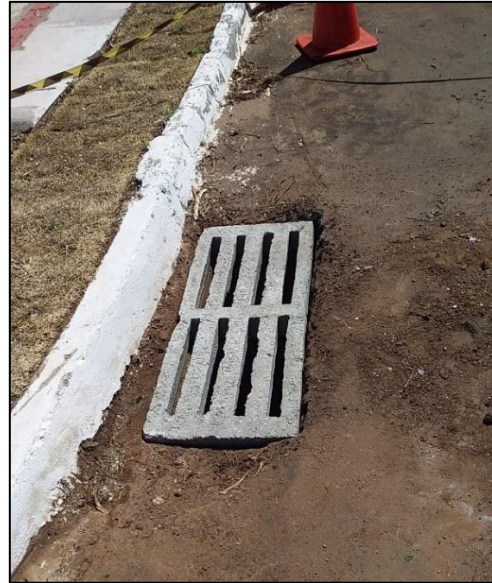
Troca de Grelha em faixa de rodagem, próximo à chegada em rotatória.
