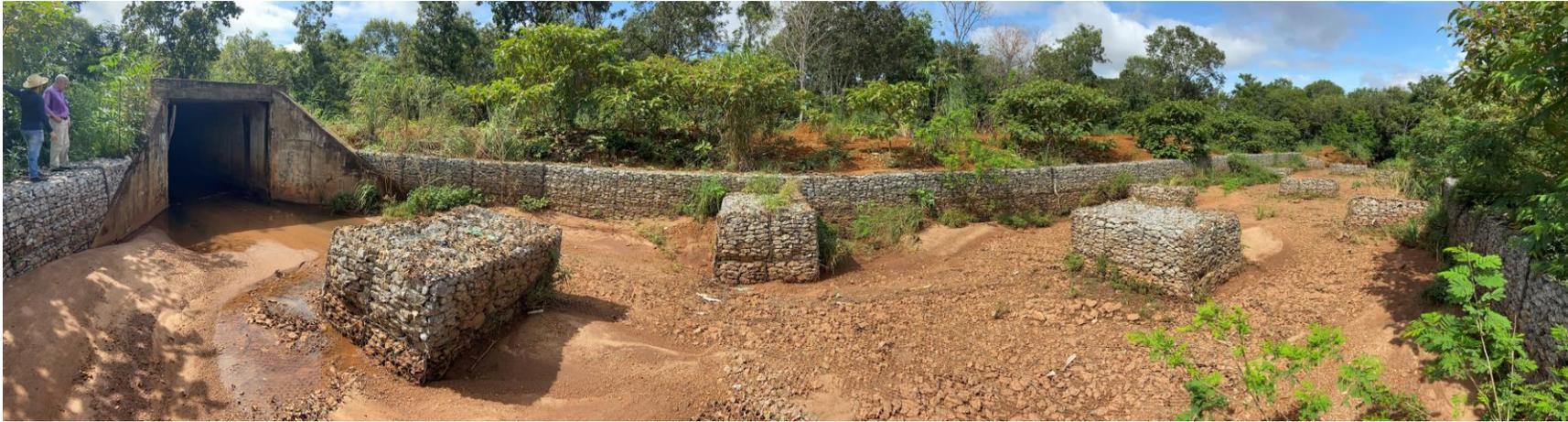
*Dispositivo de dissipação de energia – dimensionado para atendimento aos parâmetros de projeto*
