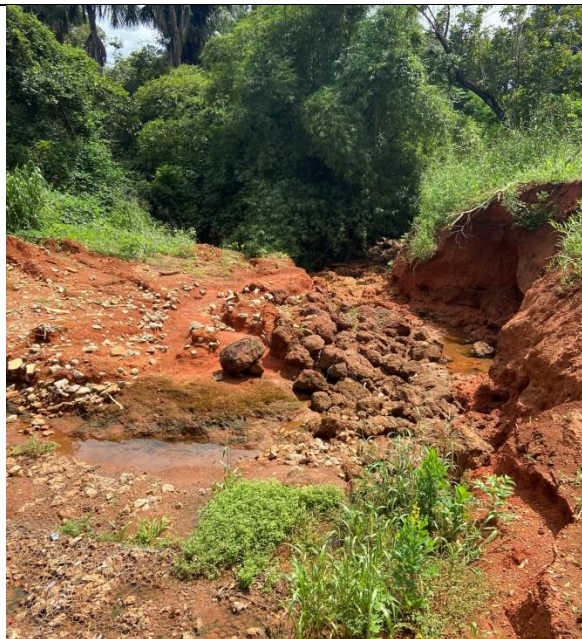
Ravinamento, imediatamente à jusante do dispositivo.
