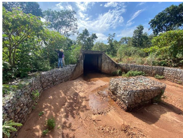
Blocos de dissipação de energia apresentam deformações e perda de volume (brita escapando pela malha).
