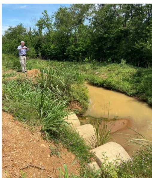
Desemboque da tubulação com assoreamento, falta de manutenção preventiva e escoamento prejudicado.
