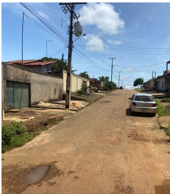
Pavimentação sem guias nem bueiros
