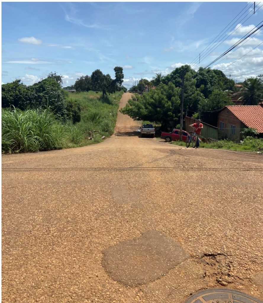
Fundo de vale de afluente do Córrego Machado, sem devida estrutura de coleta de águas pluviais.
