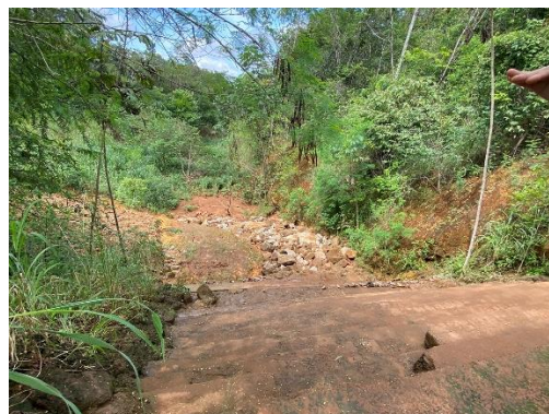
Altas vazões e velocidade de escoamento ocasionando carreamento de pedregulhos
