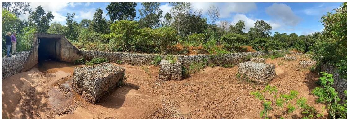
Vista Panorâmica da estrutura
