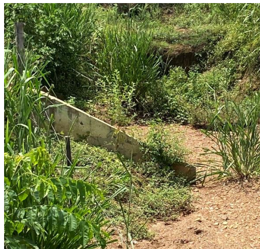
Emboque da tubulação de drenagem, observa-se assoreamento.
