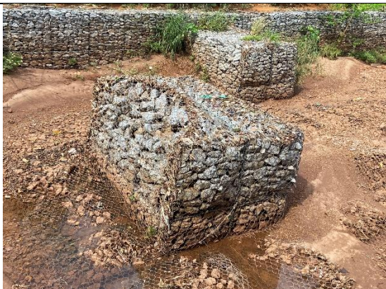
Assoreamento. Falta de manutenção preventiva (limpeza e dragagem)
