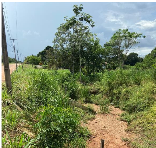
Emboque da tubulação de drenagem, observa-se assoreamento.
