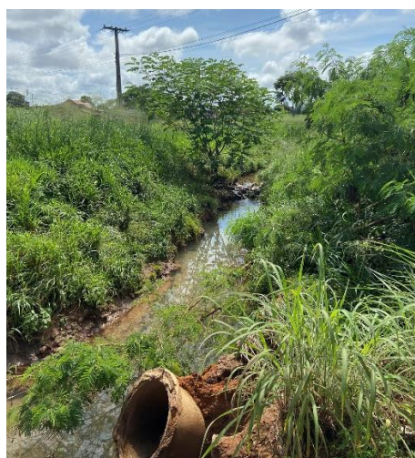
Estrutura assentada superficialmente, sem adequado alicerçamento sob via de circulação
