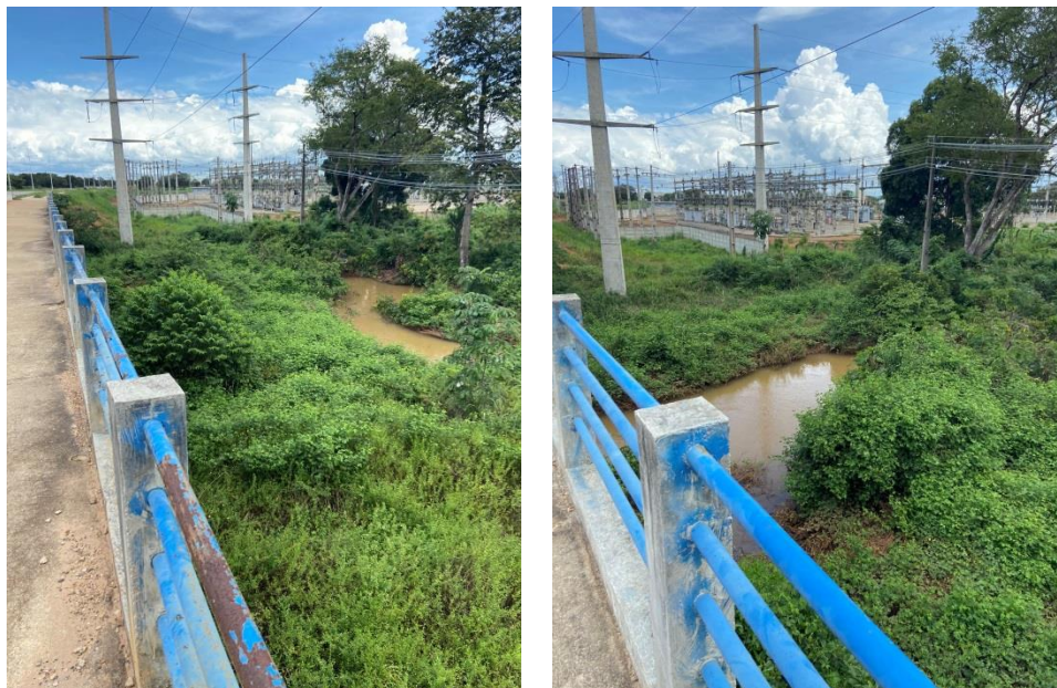
Vista Geral do curso da descarga de águas no Córrego.
