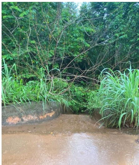
Descarga de drenagem superficial da via.
