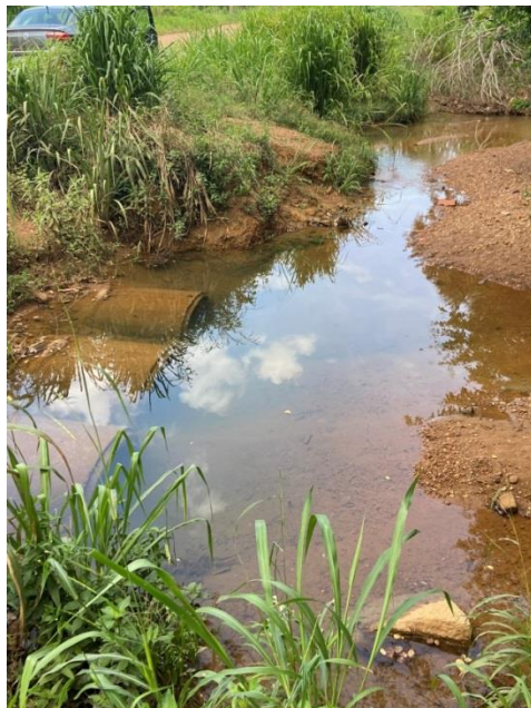
Desemboque da tubulação com assoreamento, falta de manutenção preventiva e escoamento prejudicado.
