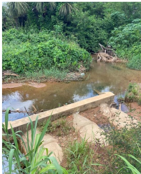
Emboque dos tubos de drenagem, observa-se assoreamento e manutenção (limpeza e dragagem) precária.
