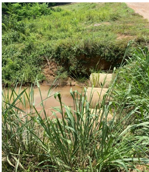
Desemboque da tubulação com assoreamento, falta de manutenção preventiva e escoamento prejudicado.
