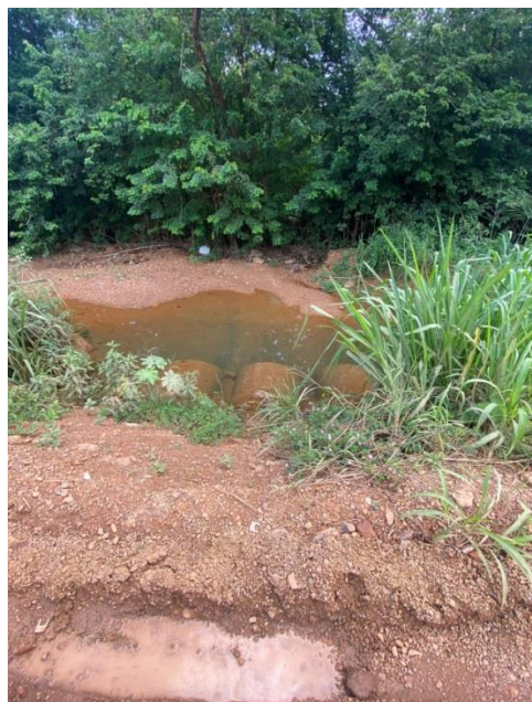
Desemboque da tubulação com assoreamento, falta de manutenção preventiva e escoamento prejudicado.
