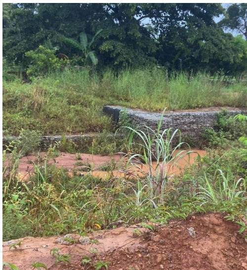
Dispositivo de lançamento em estrutura de Gabiões, observa-se assoreamento e falta de manutenção (vegetação muito alta, assoreamento)
