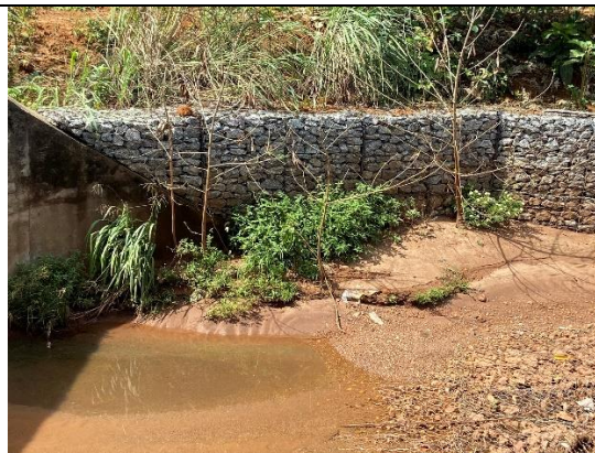
Assoreamento. Falta de manutenção preventiva (limpeza e dragagem)
