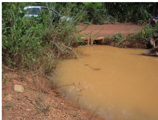
Vista do tubo de descarga sob a via
