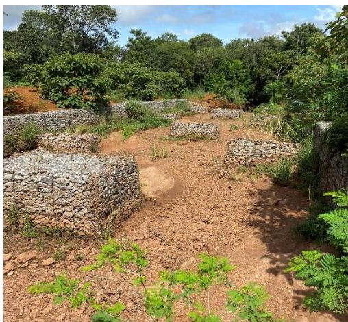
Blocos de dissipação de energia apresentam deformações e perda de volume (brita escapando pela malha).
