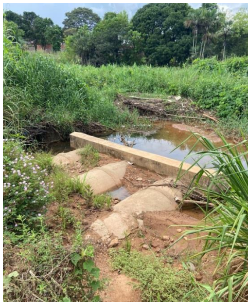
Emboque dos tubos de drenagem, observa-se assoreamento e manutenção (limpeza e dragagem) precária.
