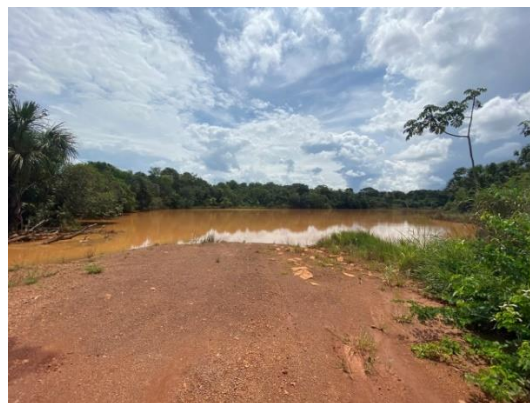
Represa Lago Norte à montante.
