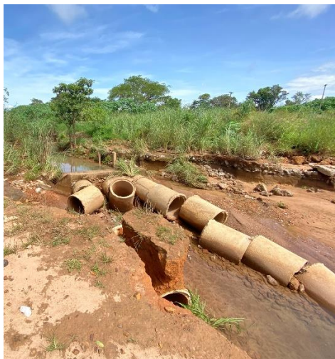
Estrutura colapsada
