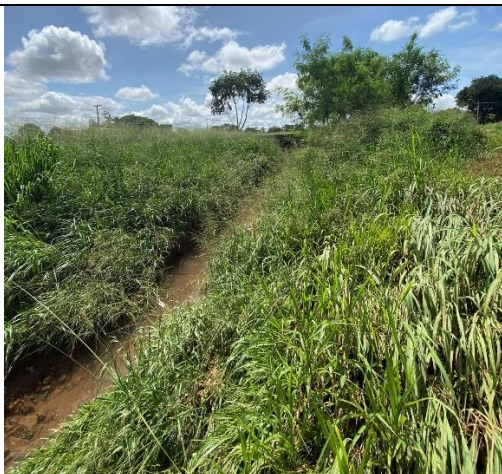
Canal de drenagem (vista à montante)
