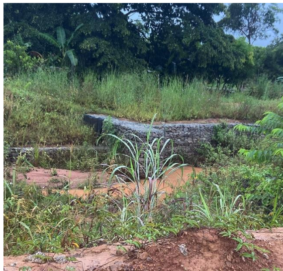
Dispositivo de lançamento em estrutura de Gabiões, observa-se assoreamento e falta de manutenção (vegetação muito alta, assoreamento)
