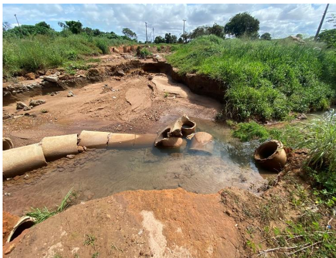
Estrutura assentada superficialmente, sem adequado alicerçamento sob via de circulação
