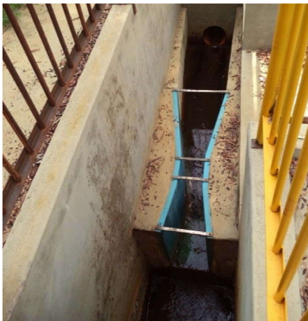
Figura 74. Calha Parshall de Saída
