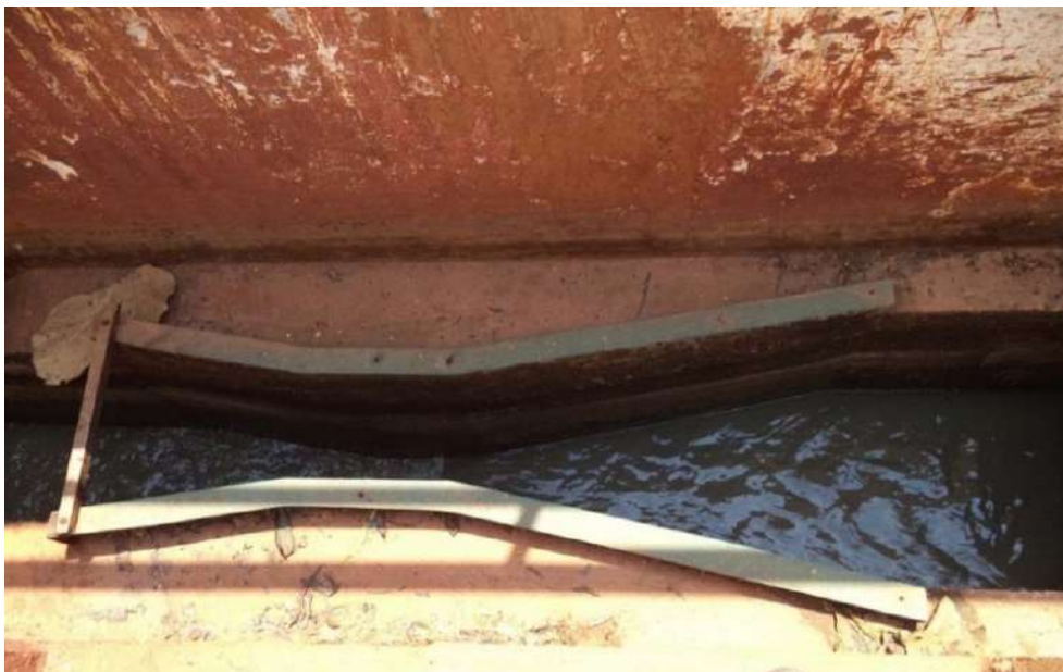
Figura 69. Calha Parshall de entrada
