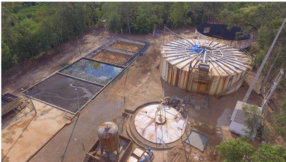
Figura 78. Estação de Tratamento de Esgoto – ETE Prata
