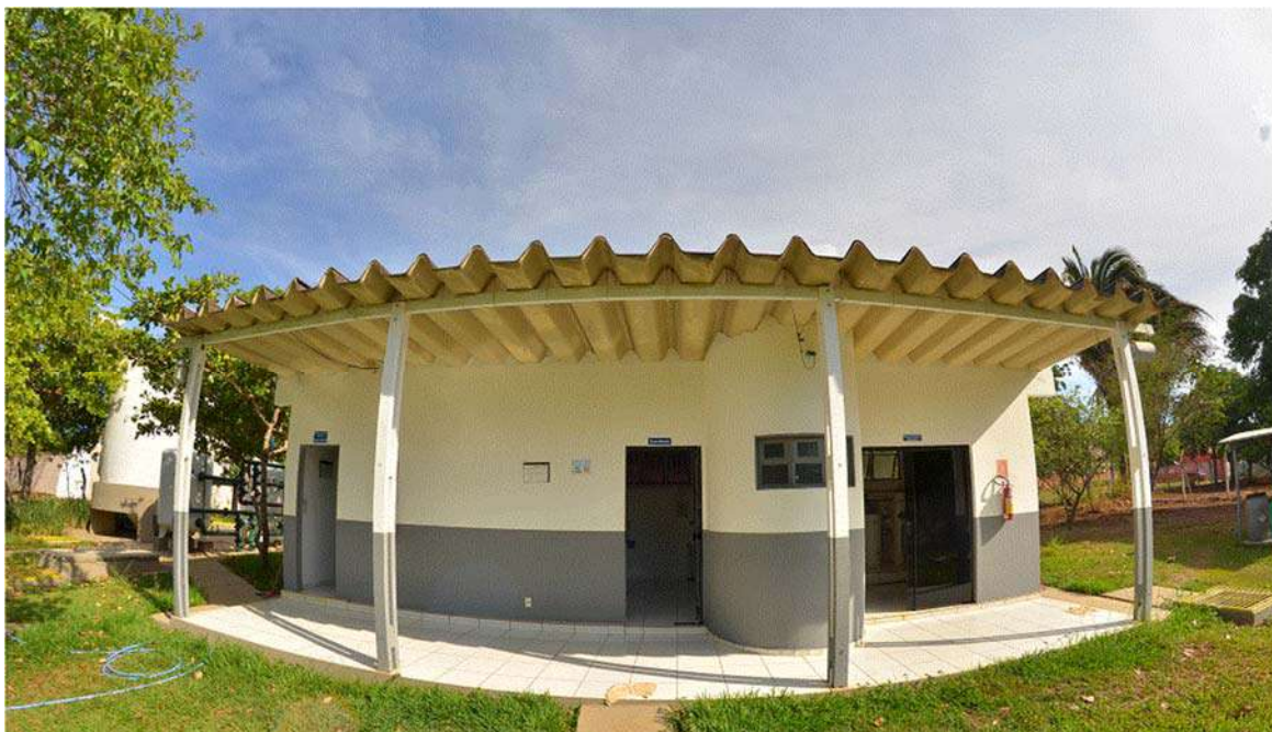
Figura 59. Laboratório e casa de química
