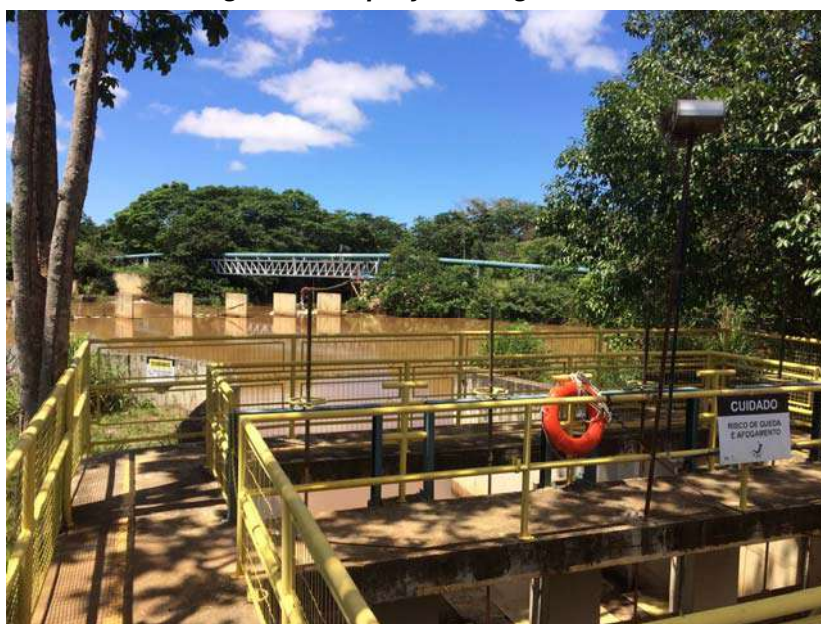
Figura 19. Captação de água bruta
