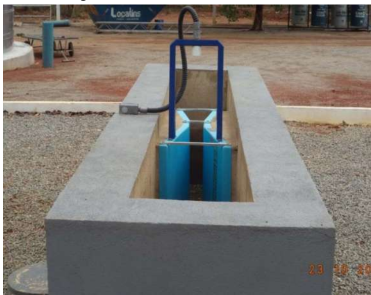
Figura 115. Calha Parshall de saída 6"
