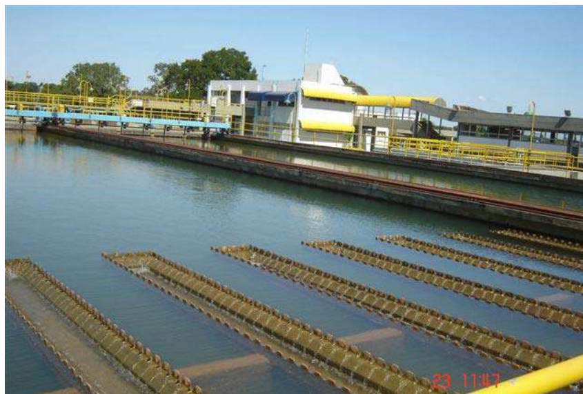
Figura 24. Tanques de decantação ETA 6 – Sistema Taquarussu
