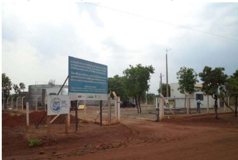
Figura 109. Estação de tratamento de esgoto Santa Fé
