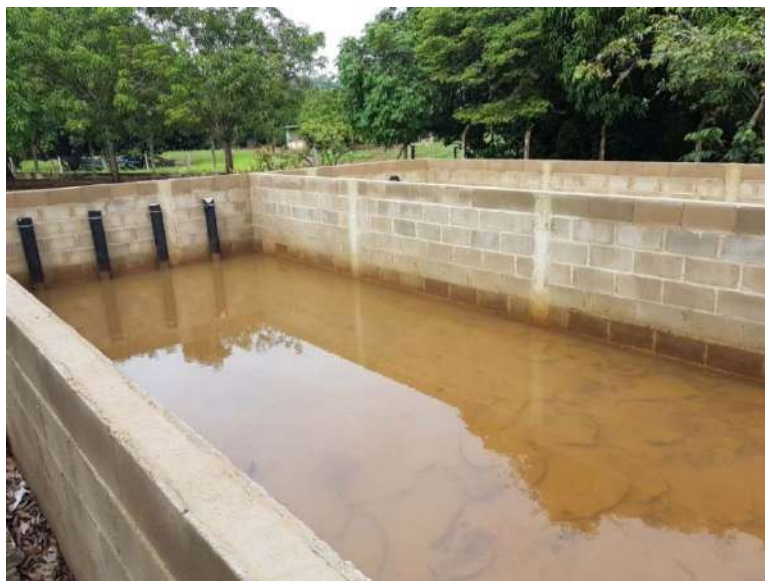
Figura 39. Tratamento da água de lavagem dos filtros
