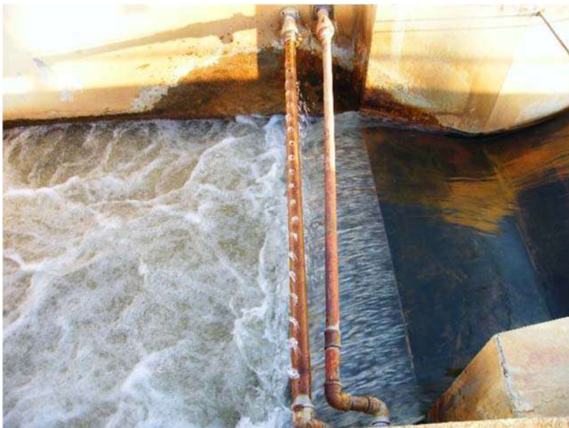
Figura 22. Calha Parshall
