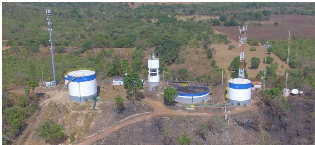
Figura 32. Reservatórios apoiados – RAP 003, 004, 010 e 019 ( CR Taquaralto)
