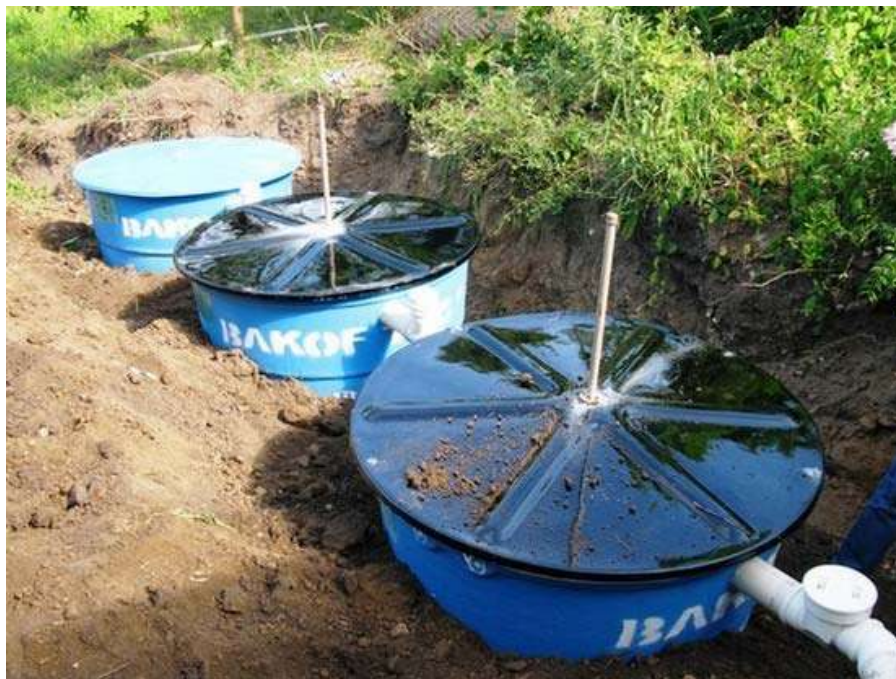
Figura 124. Modelo simplificado de tratamento de esgoto em comunidades rurais (EMBRAPA)
