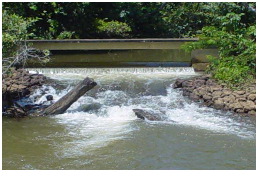
Figura 34. Local de captação ETA 003 – Sistema Água Fria
