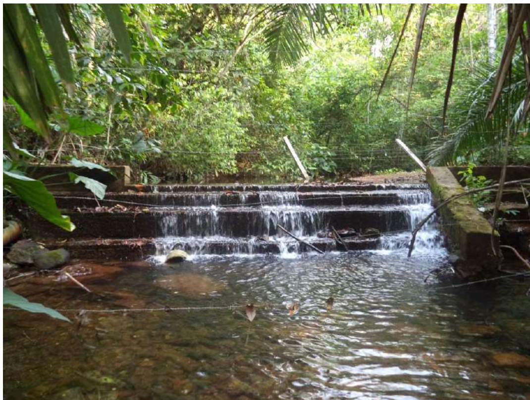
Figura 57. Captação ETA 007 – Córrego Roncador
