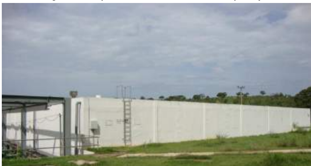
Figura 28. Tanque de contato/Reservatório de compensação
