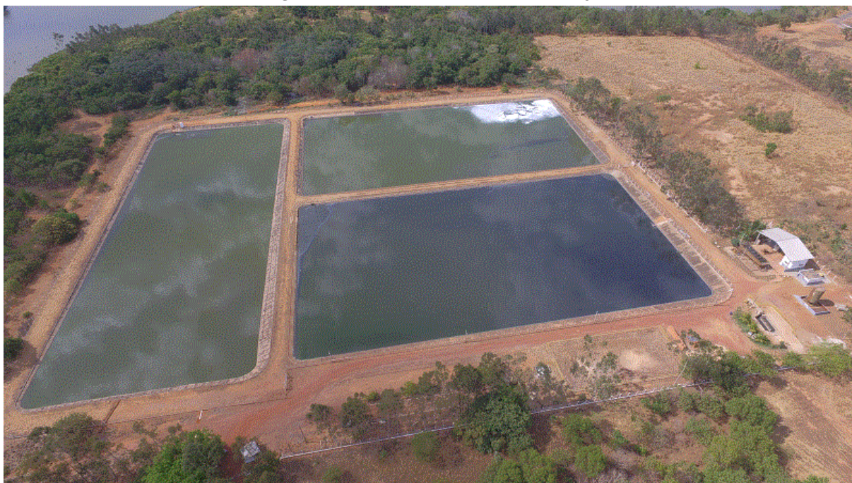
Figura 66. Vista aérea da ETE Aurenny
