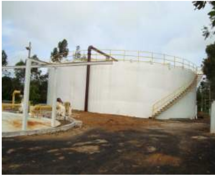
Figura 80. Reator UASB – ETE Prata
