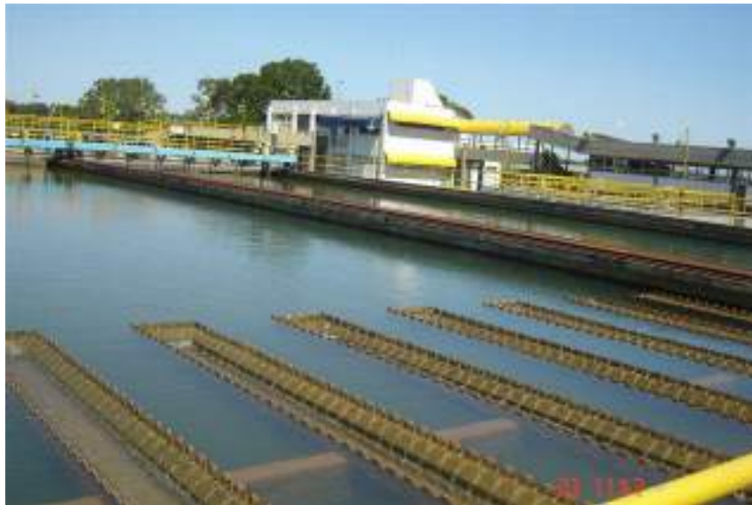
Figura 24. Tanques de decantação ETA 6 – Sistema Taquarussu
