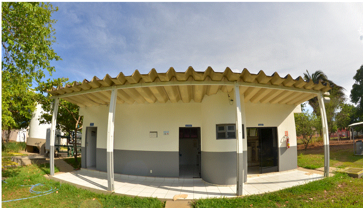
Figura 59. Laboratório e casa de química
