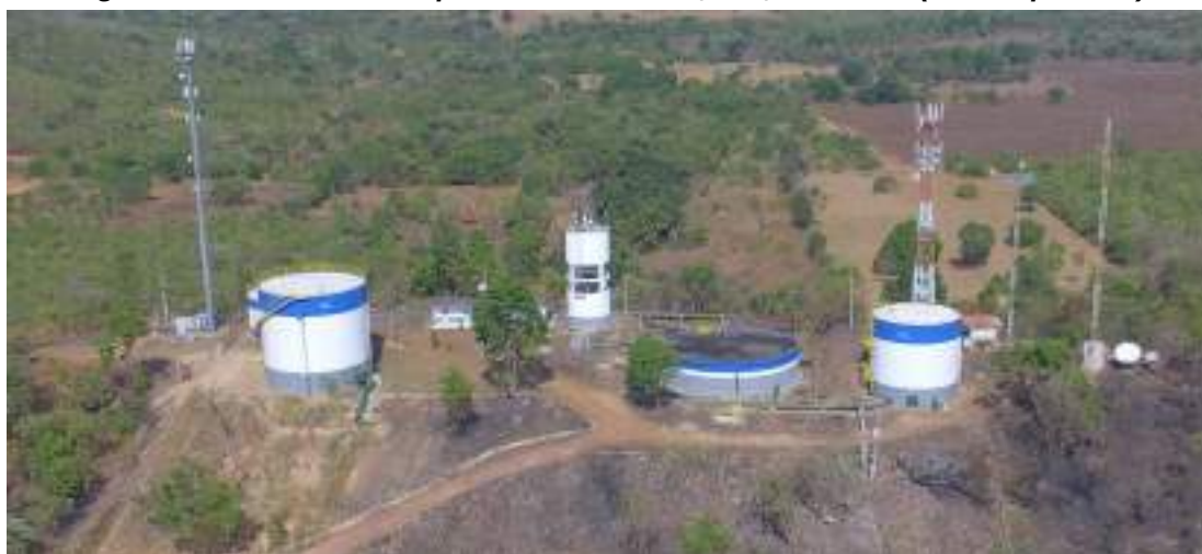
Figura 32. Reservatórios apoiados – RAP 003, 004, 010 e 019 ( CR Taquaralto)
