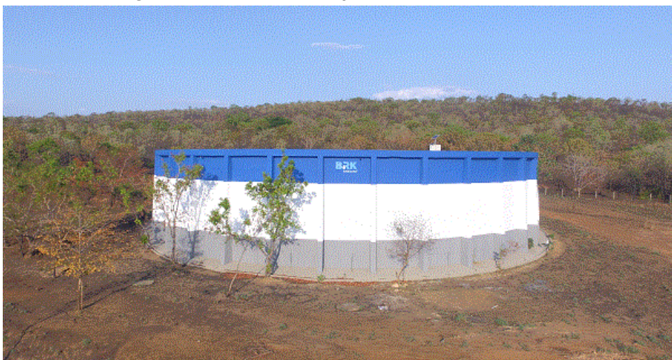
Figura 43. Reservatório Apoiado - RAP 002
