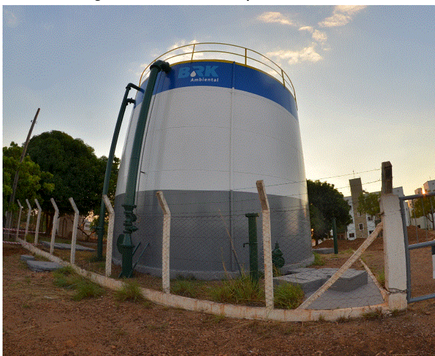
Figura 44. Reservatório Apoiado - RAP 006
