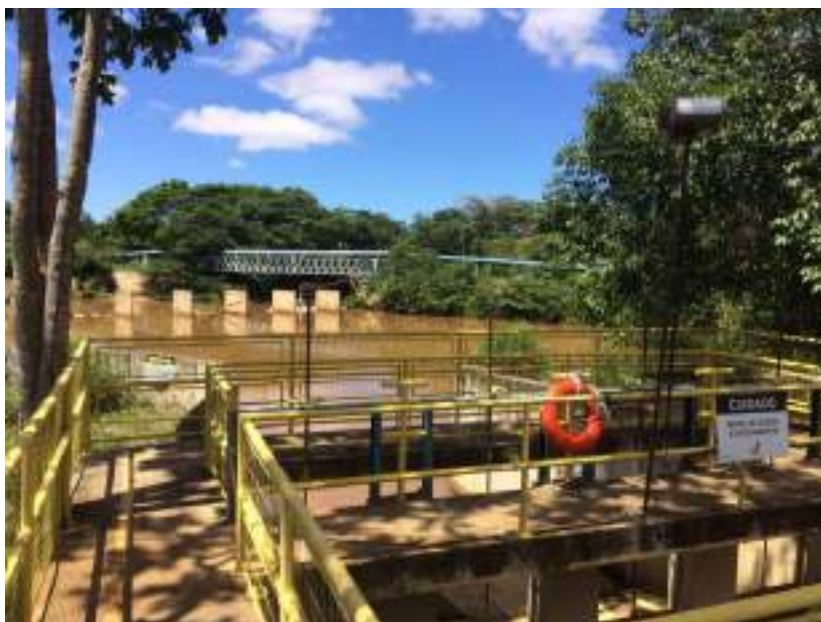
Figura 19. Captação de água bruta
