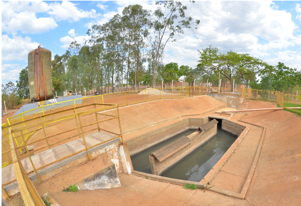
Figura 68. Desarenador
