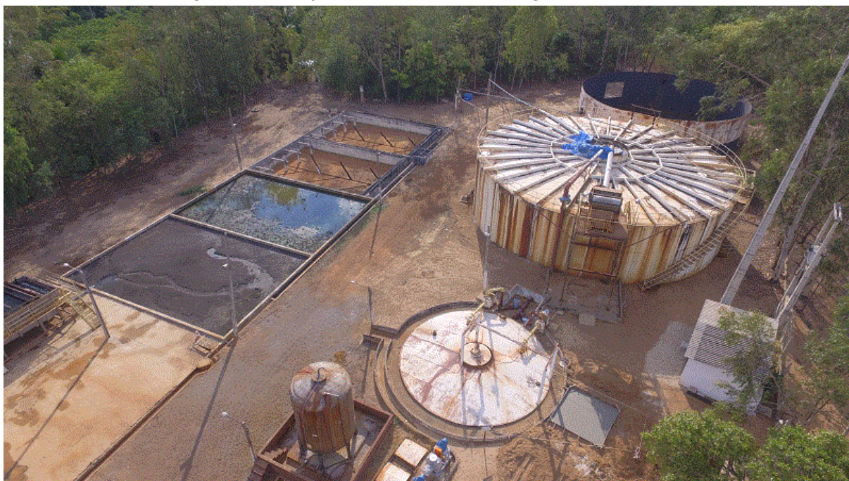
Figura 78. Estação de Tratamento de Esgoto – ETE Prata
