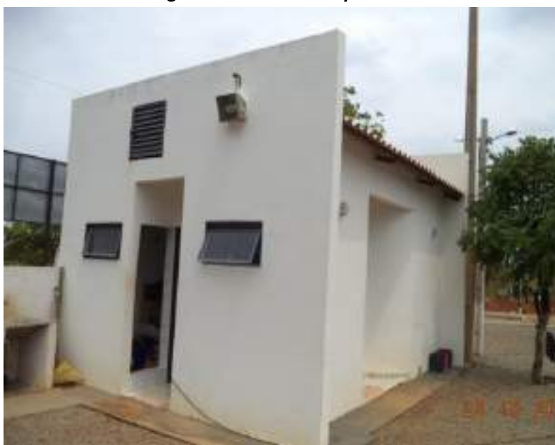
Figura 110. Casa do operador
