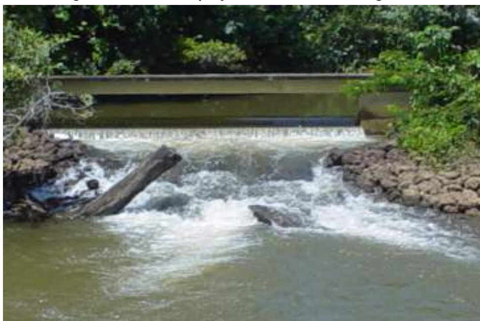
Figura 34. Local de captação ETA 003 – Sistema Água Fria
