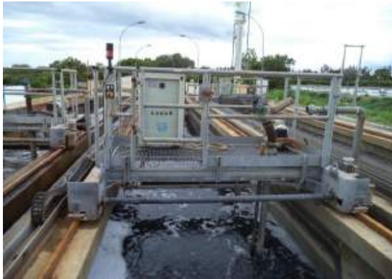
Figura 91. Desarenador rolante
