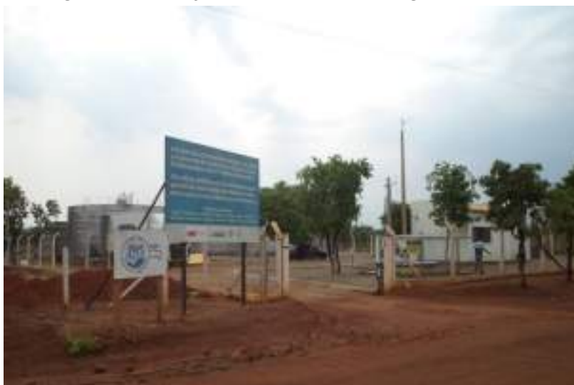
Figura 109. Estação de tratamento de esgoto Santa Fé
