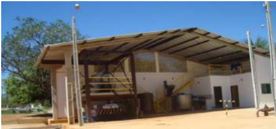
Figura 83. Casa do operador/ casa de produtos químicos/centrifuga
