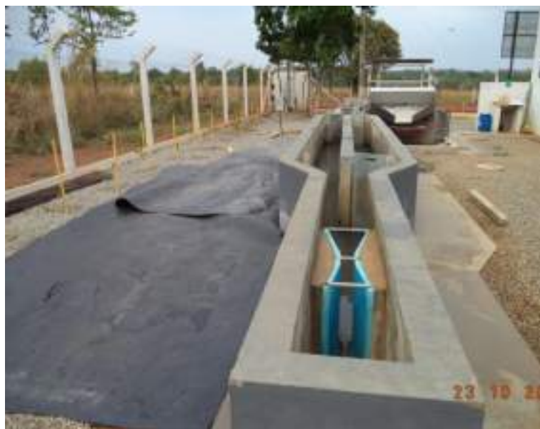
Figura 108. Desarenador
