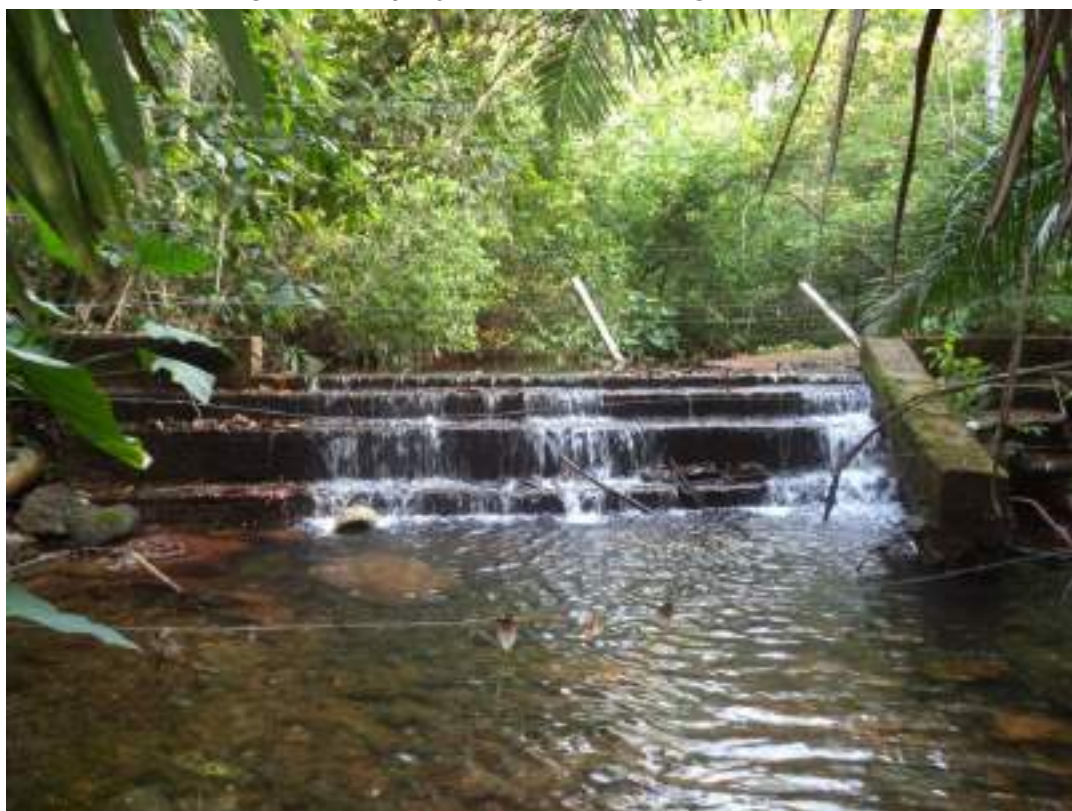
Figura 57. Captação ETA 007 – Córrego Roncador
