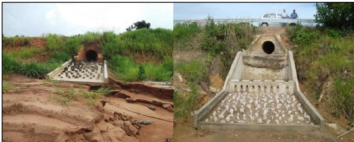
Figura 3-XV: Exemplos de rampas dentadas
