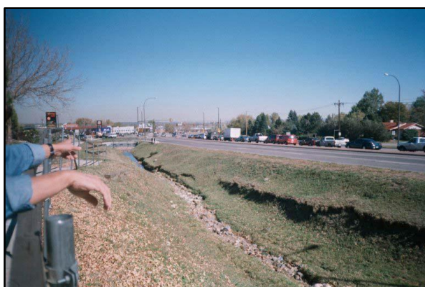
Figura 3-II: Detenções e Infiltrações em canteiros centrais de avenidas
