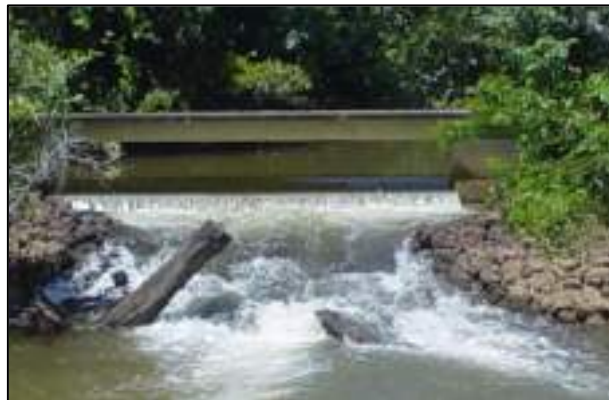
Figura 2-XVII: Captação Superficial no Ribeirão Água Fria – fonte PMAE 2018
