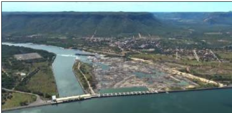
Figura 2-XII: Vista aérea da UHE Lajeado
