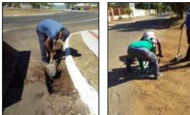
Figura 2-XLIX: Bocas de lobo em Palmas necessitam constante manutenção
