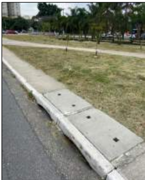
Figura 3-XXVII: Bocas de lobo de Guia combinadas (2), com depressão, e caixa de inspeção na calçada – Córrego Zavuvus, São Paulo/SP
