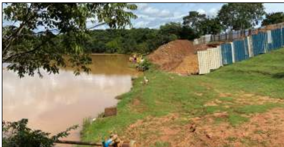
Figura 2-XLIII: Remoção do acúmulo de sedimentos no Lago Cesamar
