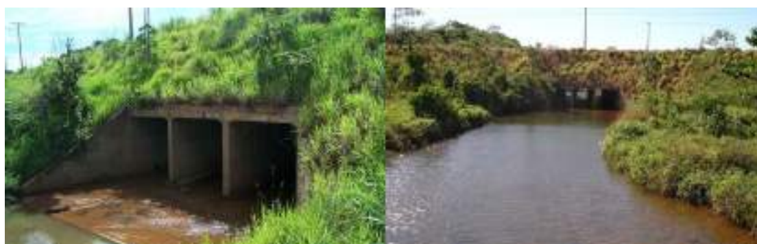
Figura 2-XXVI: Bueiro Celular sob a NS-10 (Entrada e Saída) – fonte: PMDU 2014
