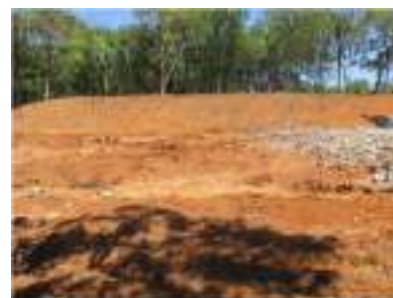
Figura 26: Talude sem cobertura vegetal no entorno da obra de drenagem.
