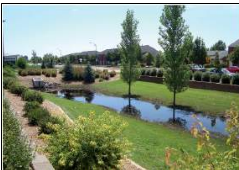
Figura 3-XII: Exemplo de reservatório de retenção alagado (Colorado, EUA)
