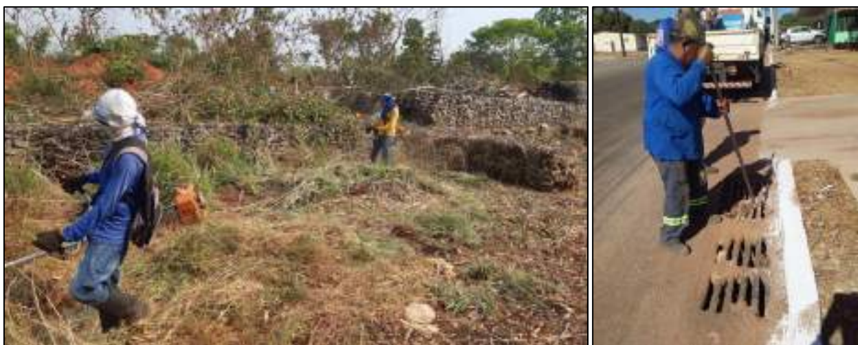
Figura 2-LII: Supressão da vegetação (roçagem) e desobstrução de bocas de lobo
