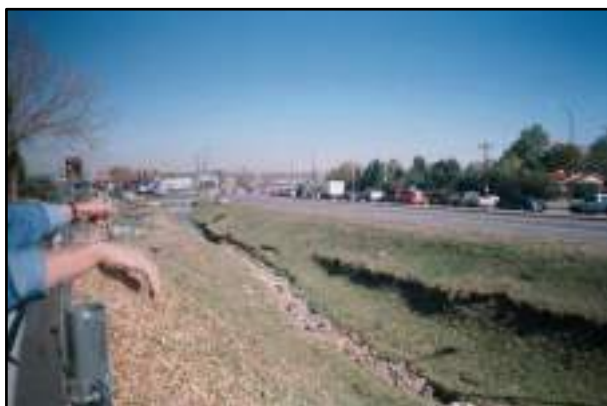
Figura 3-V: Detenções e Infiltrações em canteiros centrais de avenidas
