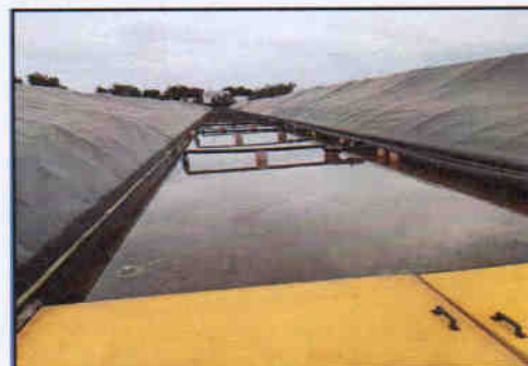
Foto 13- Acumulo de água entre reatores.
