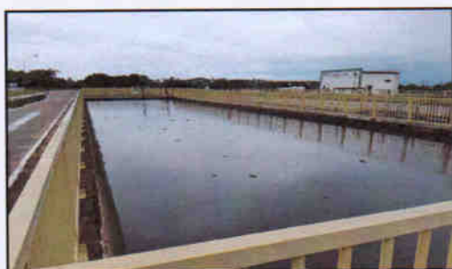
Foto 16 – vista geral do decantador.
