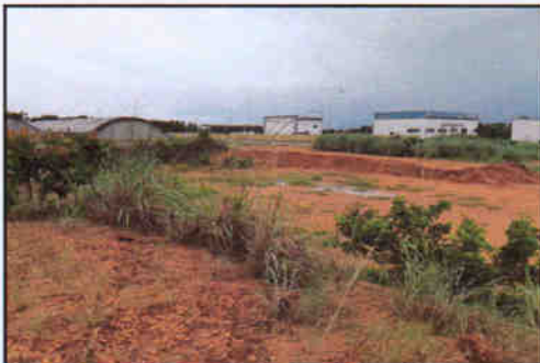
Foto 32 – Área para futuras ampliação do sistema, foi identificado solo em processo erosivo.
