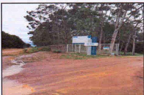
Foto 1 – Vista da entrada da Estação de tratamento Norte, com devida sinalização.
