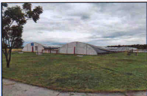
Foto 12- Vista do Estrutura dos reatores anaeróbios.
