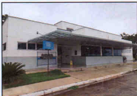
Foto 3 – Vista do prédio de controle e processos da ETE.
