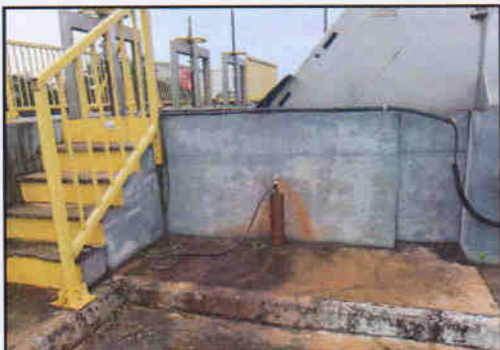
Foto 8- Torneira com mangueira sem identificação e informação do tipo de líquido e advertência quanto ao uso.
