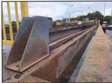
Foto 9- vista da vala do decantador com água da chuva.
