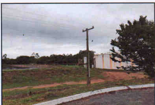
Foto 10- Vista da estrutura antiga e desativada.
