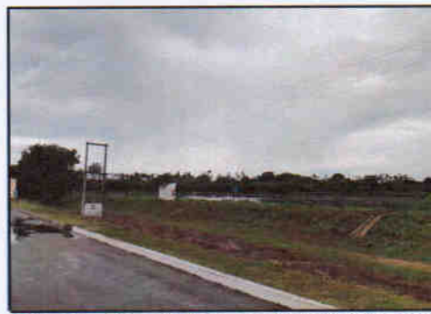
Foto 11 - Vista da lagoa aerada que funciona como equalizador de vazão.
