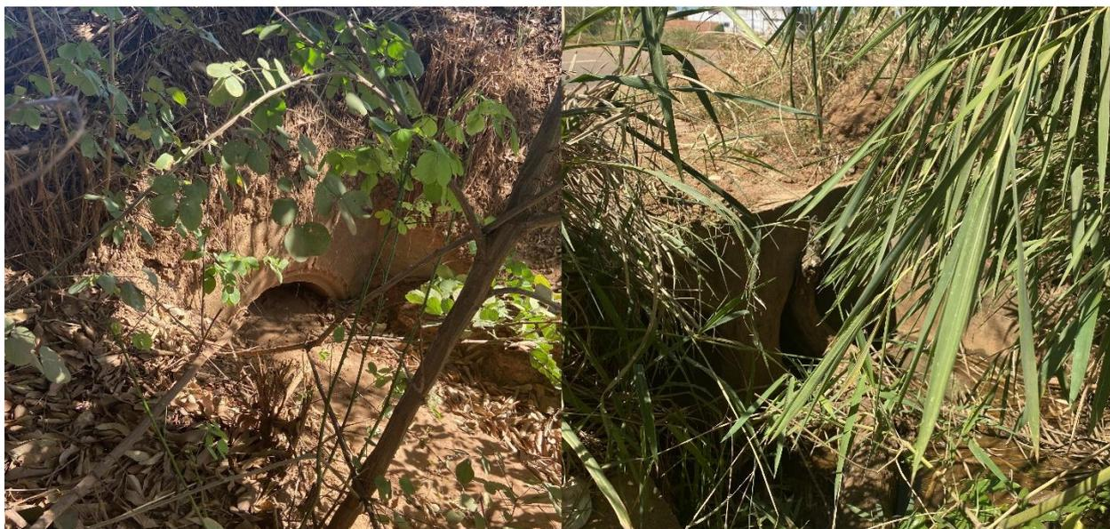
**FIGURA 1-XIV: Tubulações de passagem com seção reduzida, com comprometimento quase total do funcionamento**
