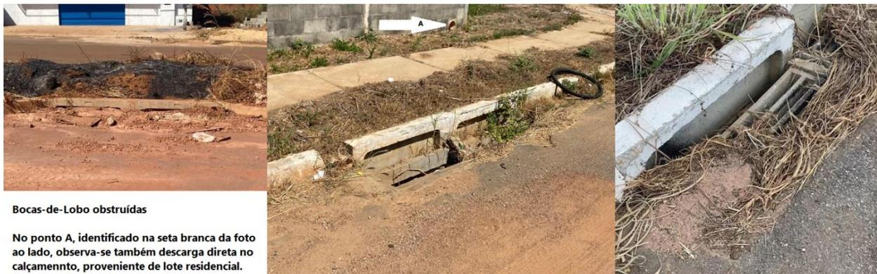
**FIGURA 1-XIII: Exemplos de Bocas-de-Lobo obstruídas**
