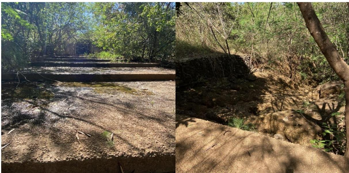
**Condição em 2022: significativo adensamento da vegetação e carreamento completo do enrocamento que existia à jusante**
